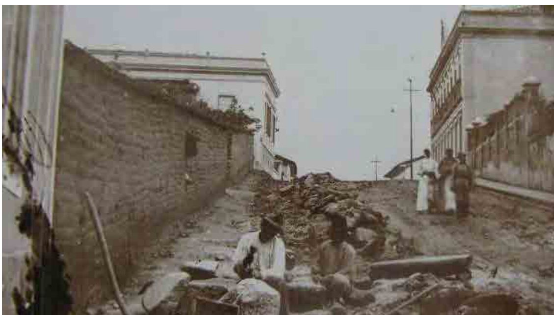
Figura 33 - Assentamento dos trilhos do bonde, 1900 - Fonte: Museu Frei Galvão
