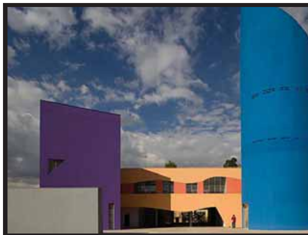
Figura 57 – Centro de convivência de Heliópolis – Ruy Ohtake Fonte: www.ruyohtake.com.br - acessado em 5/10/2010.
