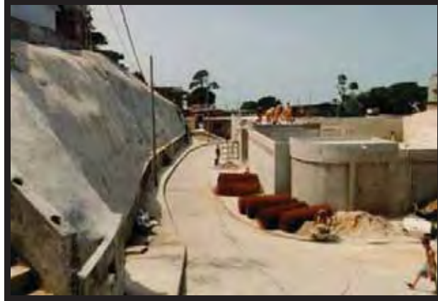
Figura 45 – Contenção de encostas. Fonte: http://www.prourb.fau.ufrj.br/cidades/favela - acessado em 22/10/2010.
