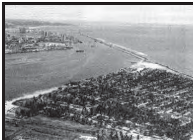
Figura 27 – Brasília Teimosa na época de intensa ocupação irregular, 1975. Fonte: BRAGA, 2002.
