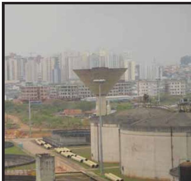
Figura 63 – Edifícios residenciais de Ruy Ohtake em processo de execução, em segundo plano na foto. Foto: Leticia F. de Oliveira, 29/09/2010.
