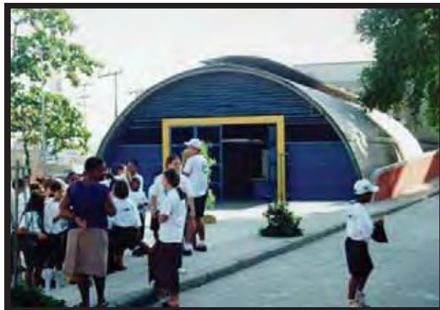
Figura 46 - Antigo galpão militar: centro comunitário, na Ladeira dos Funcionários. Fonte: http://www.prourb.fau.ufrj.br/cidades/favela - acessado em 22/10/2010.
