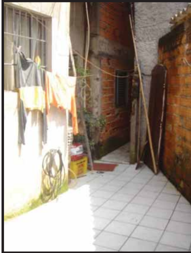
Figura 70 – Estrangulamento de uma viela, dificultando a iluminação e ventilação da edificação. Foto: Leticia F. de Oliveira, 29/09/2010.
