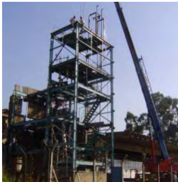
Figura 3: Acima se observa o início do desmantelamento de instalação nuclear com a retirada do fechamento lateral para remoção de elementos contaminados. A foto inferior ilustra uma fase mais avançada do desmantelamento da estrutura do edifício (Santos, 2008).
