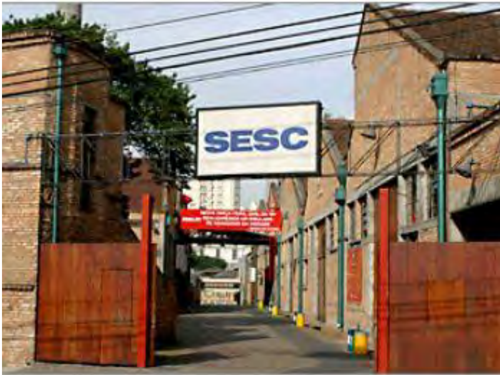
Figura 1: Instalações do SESC – Pompéia (Serviço Social do Comércio), em São Paulo, antigo edifício da Fábrica de Tambores, revitalizado por ser patrimônio arquitetônico da cidade. ( http://www.samshiraishi.com/sesc-pompeia/ ).
