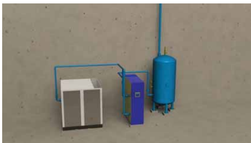
Figura 19 - Simulação da instalação do compressor, secador e reservatório de ar comprimido.
