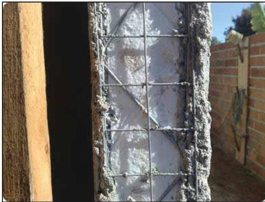
Figura 108: Detalhe painéis monolíticos. Fonte: <http://www.mundi-eps.com.br/paineis-auto-portantes-sistema-monolitico.html>
