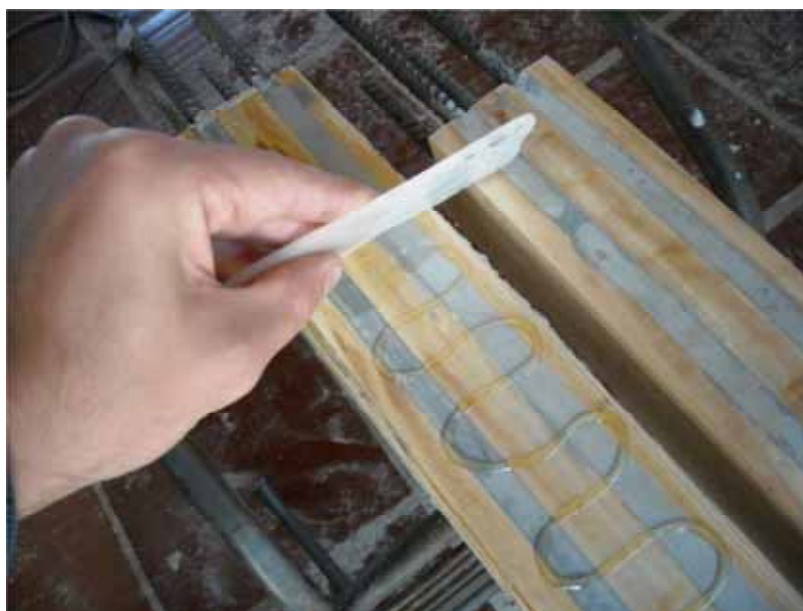
Figura 8 - Aplicação do adesivo Cascola PU
