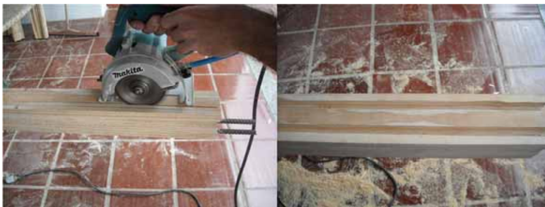
Figura 10– Abertura do sulco para acomodação dos vergalhões
