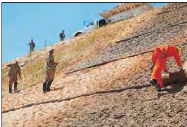
Figura 20 – Demonstração da aplicação de hidrossemeadura (Fonte: Couto et al., 2010).
