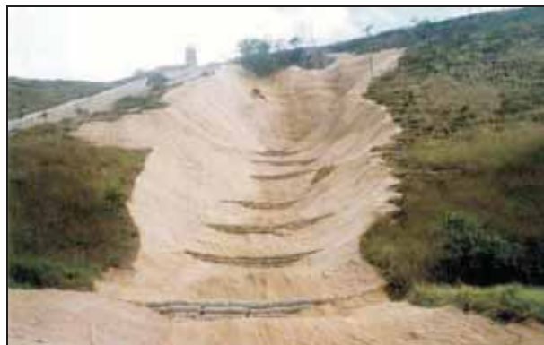
Figura 54 – Utilização de bermalongas como retentores de sedimentos.
