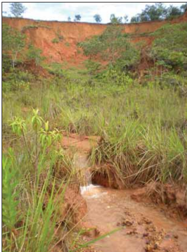
Figura 53 – Ocorrência de fluxo superficial perene no interior da voçoroca.
