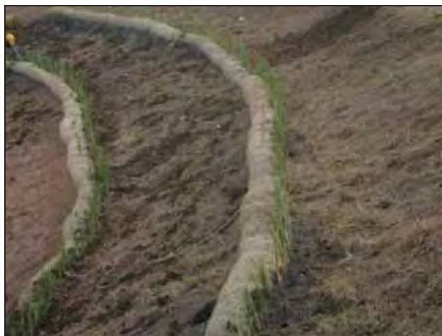
Figura 13 – Utilização de bermalongas associada ao plantio de capim Vertiver SP (Fonte: Couto et al., 2010).
