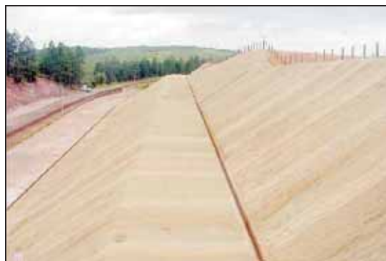
Figura 10 – Aspecto visual do talude onde foi aplicada biomanta (Fonte: Couto et al., 2010).
