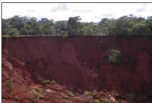
Figura 40 – Erosão em sulcos identificada na principal voçoroca de Costa Rica (MS).
