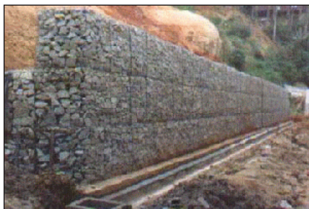
Figura 48 – Muro de gravidade flexível em gabião.
