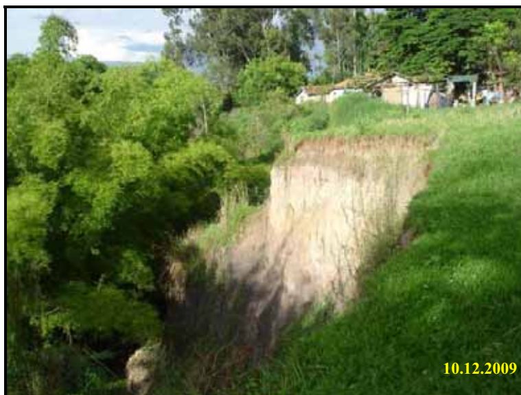
Foto 13 - Voçoroca do bairro Nossa Senhora da Paz em 10 de dezembro de 2009.
