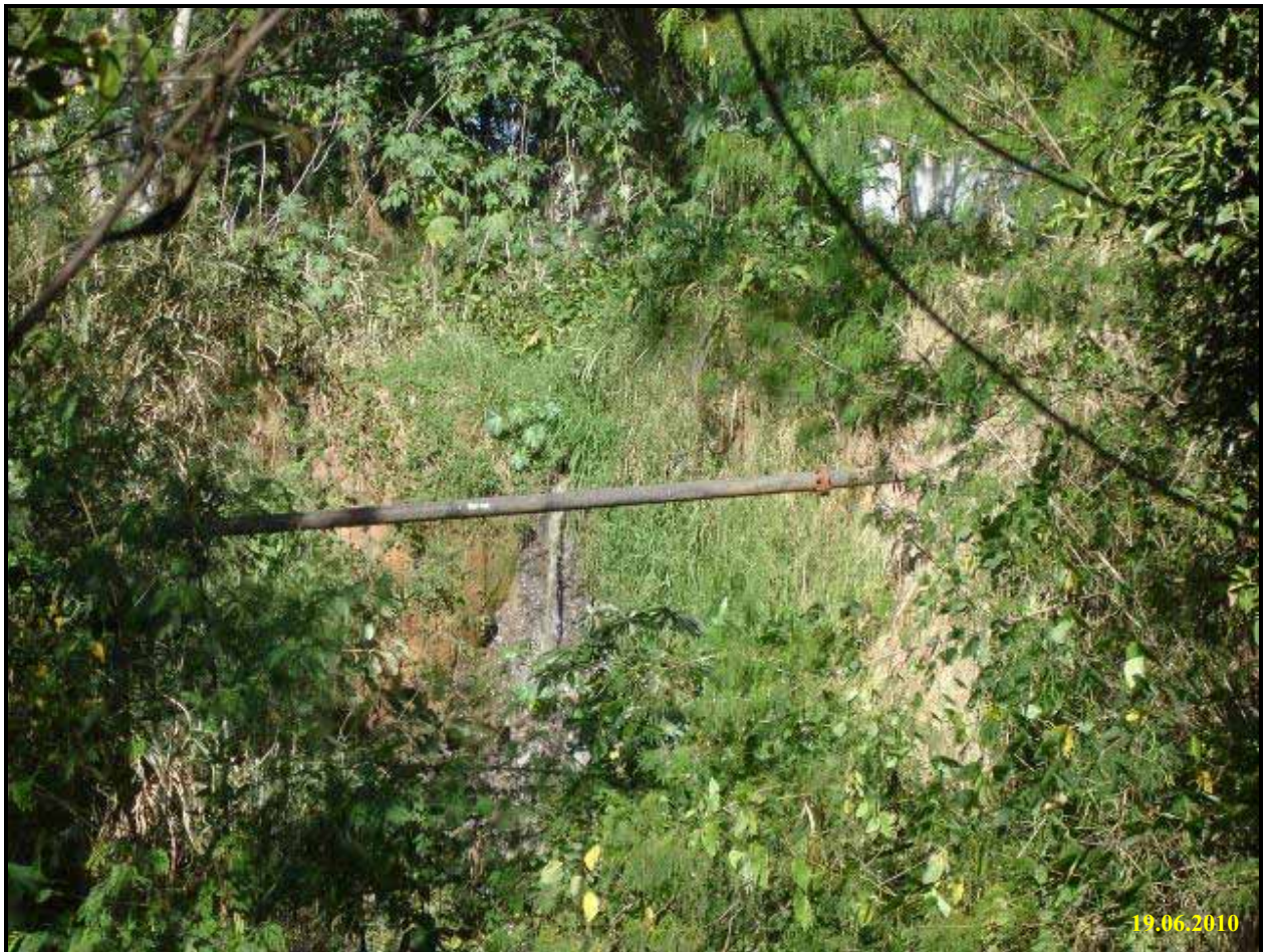
Foto 18 - Cascata de efluentes na antiga Estação de Tratamento de Esgoto da SABESP.
