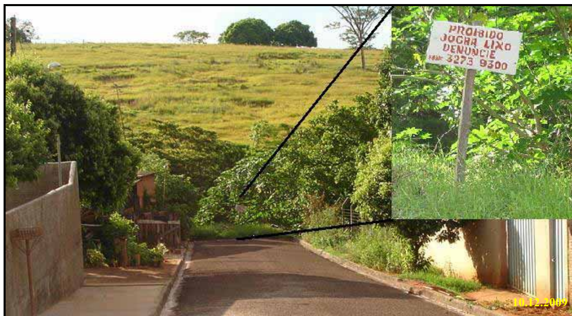
Foto 20 - Asfaltamento e ocupações estabelecidas até o fundo de vale e placa indicativa da proibição de depósito de lixos.
