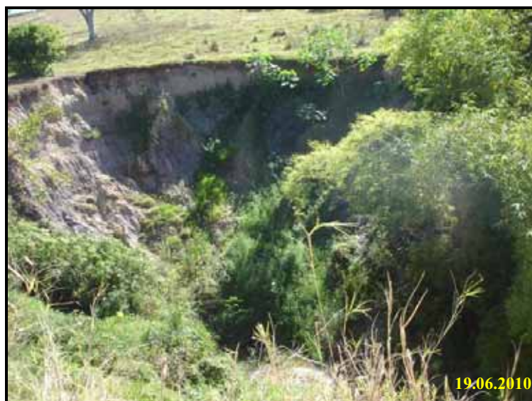
Foto 15 - Voçoroca do bairro Nossa Senhora da Paz em 19 de junho de 2010.
