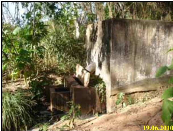
Foto 16 e 17 - Caixa cumulativa de efluentes na antiga Estação de Tratamento de Esgoto da SABESP.
