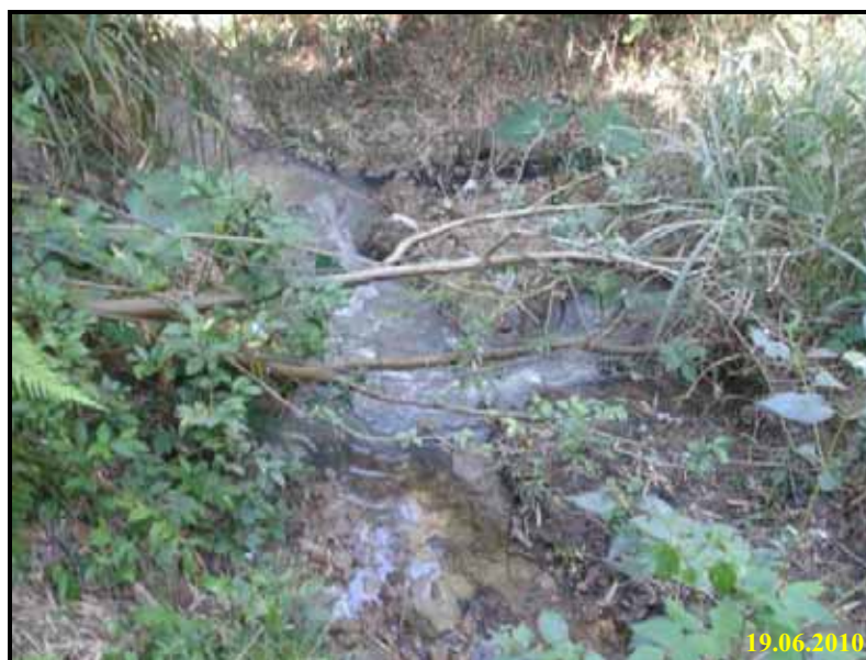
Figura 19 - Lançamento de efluentes da antiga Estação de Tratamento de Esgoto da SABESP no córrego dos Macacos.
