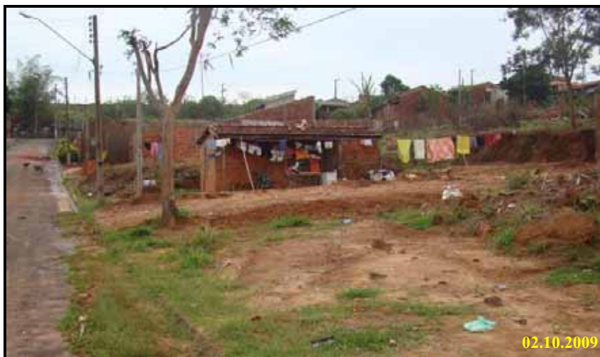
Foto 12 - Habitações de baixo padrão de construção no Jardim Santa Eugênia.
