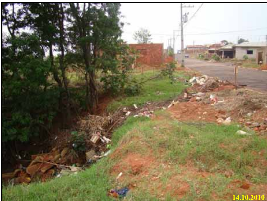
Foto 22 - Cabeceira de drenagem no Jardim São João com deposição de lixos urbanos e entulhos.
