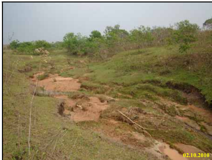
Foto 24 - Canal assoreado em área de pastagem.
