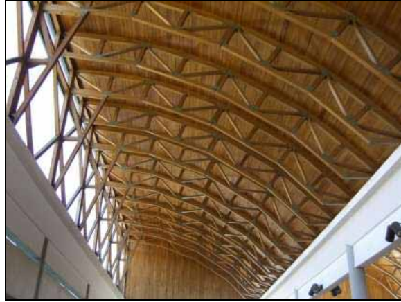
Figura 24 – Estrutura curva com ligações de CDE's
