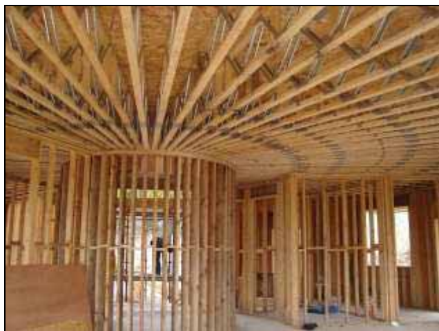
Figura 23 – Aplicação industrial do conector CDE em estruturas de madeira
