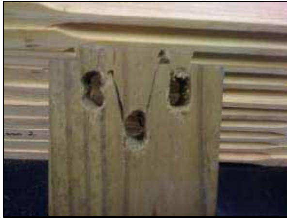
Figura 57 – Ruptura no ponto de fixação do dispositivo
