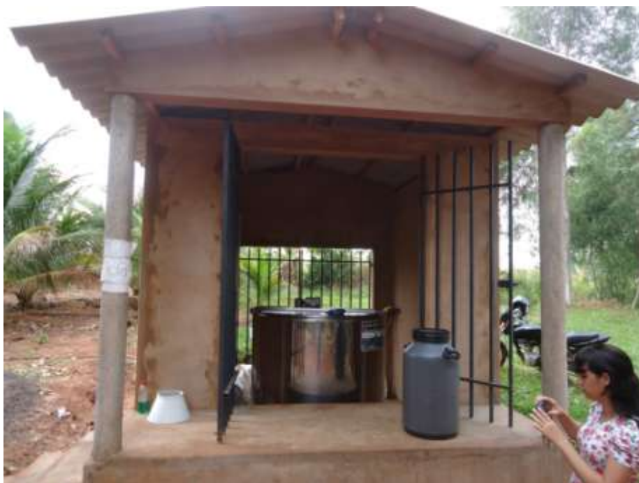
Figura 24 – Foto do Tanque de Expansão e Abrigo no Município de Euclides da Cunha Paulista – SP.
