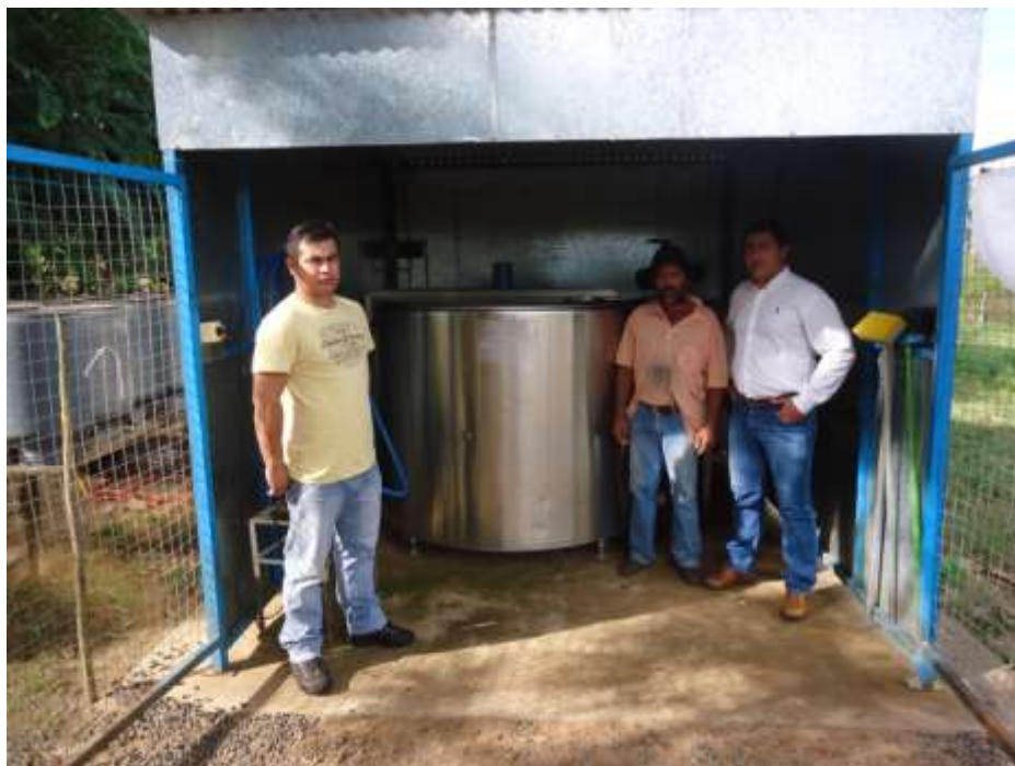
Figura 29 – Foto do Tanque de Expansão e Abrigo no Município de Marabá Paulista – SP. Fonte: Trabalho de Campo (2013)
