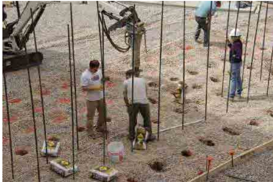
89. Processos da montagem da instalação SWAY'D, onde as varas de nylon foram concretadas no solo.
