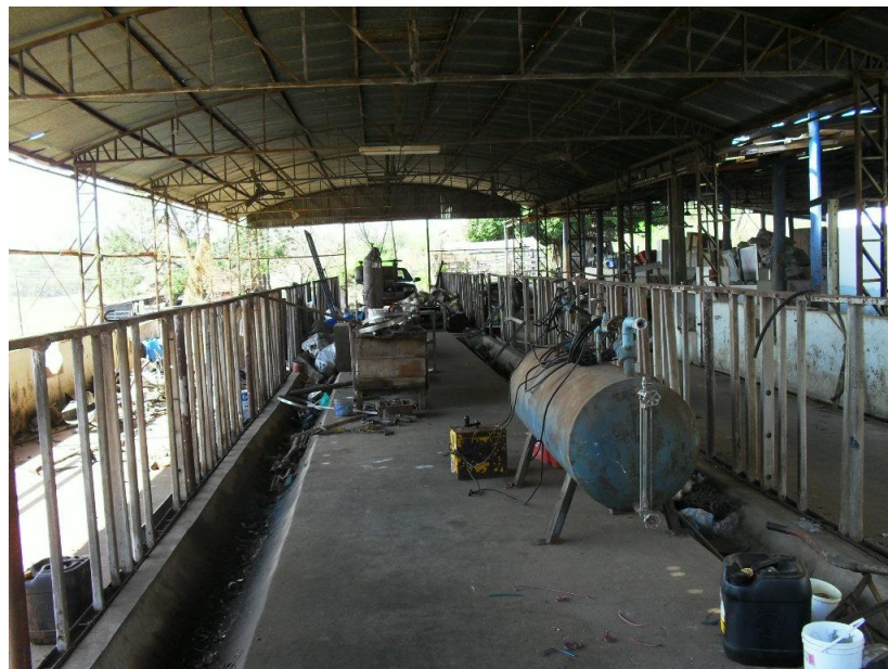
Figura 19 - Galpão ao fundo da unidade produtiva.
