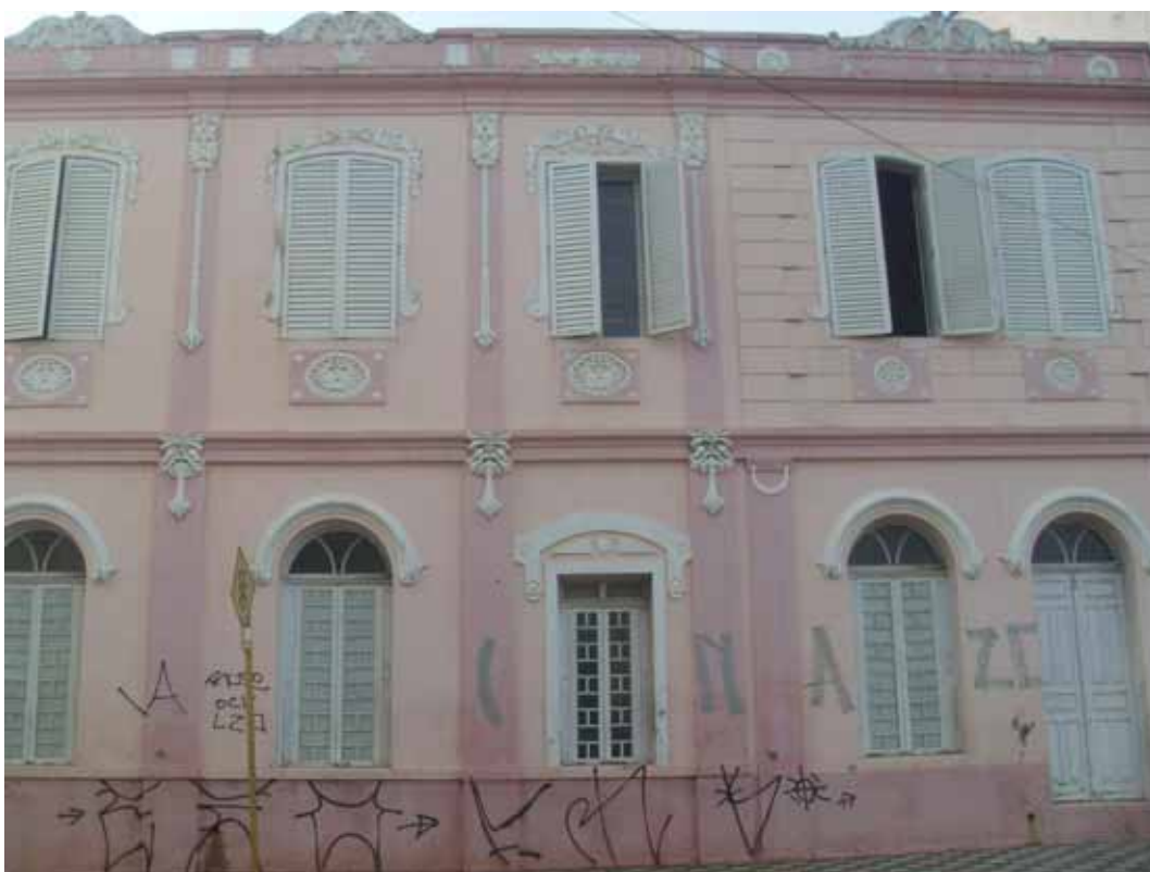
Restauração da Estação Ferroviária (acima) pode significar ganhos financeiros aos proprietários do Hotel Cariani (Bauru, maio de 2014). Crédito: Acervo do autor
