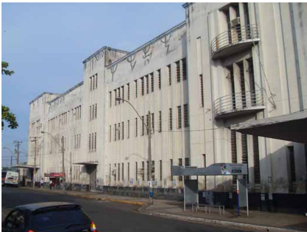
Estação da N.O.B atual (Bauru, maio de 2014). Crédito: Acervo do autor
