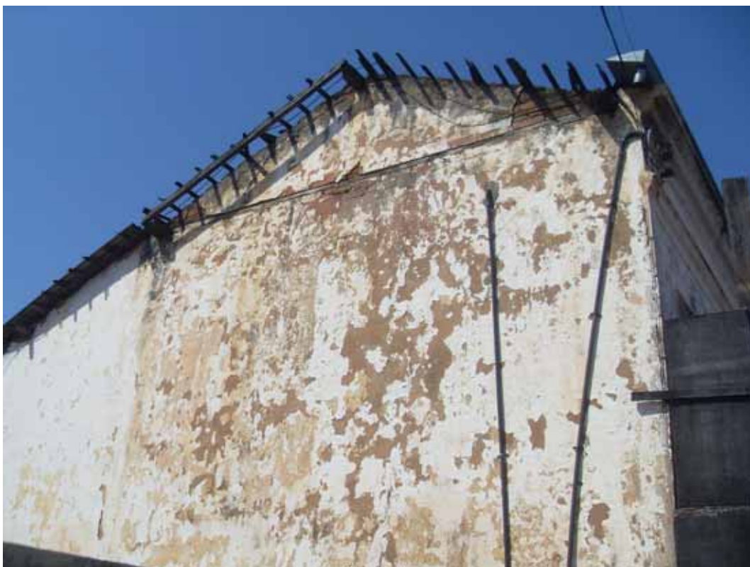
Fachadas frontal e lateral do imóvel (Bauru, outubro de 2014).
