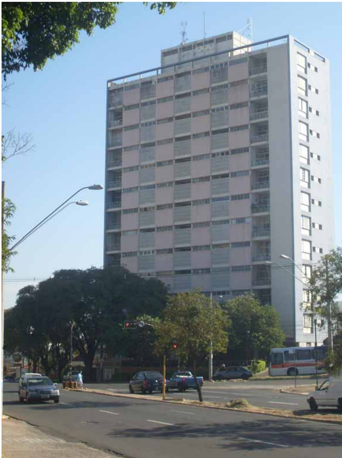
Edifício Brasil-Portugal. Imponente monumento se localiza em um dos pontos nervosos da cidade: o cruzamento Nações Unidas/Rodrigues Alves (Bauru, agosto de 2014).
