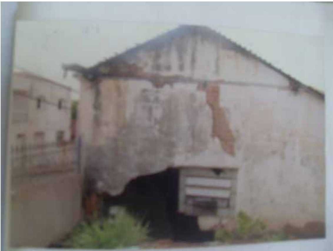
Fotos do imóvel em fevereiro de 2006. Destelhamento, caixilharia degradada e desprendimento das paredes. Crédito: Acervo do Museu Histórico de Bauru
