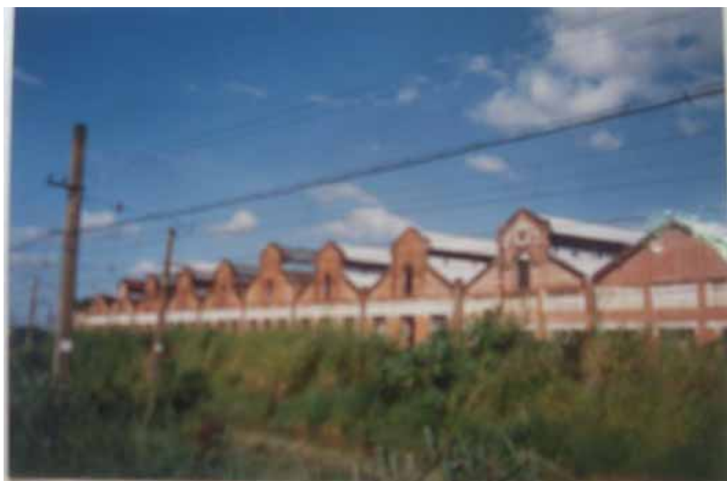
Imagem das fachadas da tecelagem dos Matarazzo. Detalhe para o formato dos módulos que serviam de arremate para o desenho das paredes (Bauru, década de 90).
