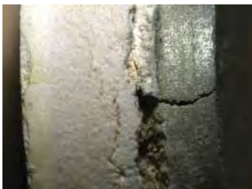
Figura 95 – Trinca na lateral da pastilha
