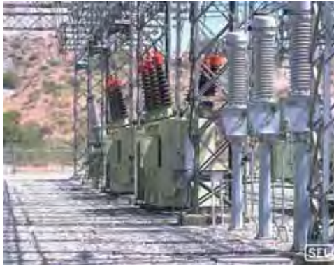
Figura 8 – Disjuntores a óleo (Fonte: www.selinc.com.br e www.sprecherschuh.com )
