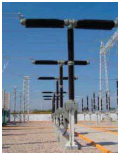
Figura 23 – Disjuntor a SF6 Siemens de AT (Fonte: www.siemens.com)
