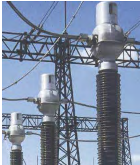
Figura 27 – Transformador de Corrente Siemens de AT (Fonte: www.siemens.com)
