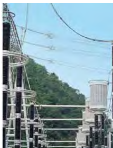
Figura 30 – Pára-raios Siemens de AT (Fonte: www.siemens.com )
