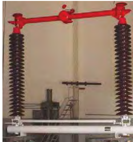
Figura 24 – Chave Seccionadora Siemens de AT (Fonte: www.siemens.com )
