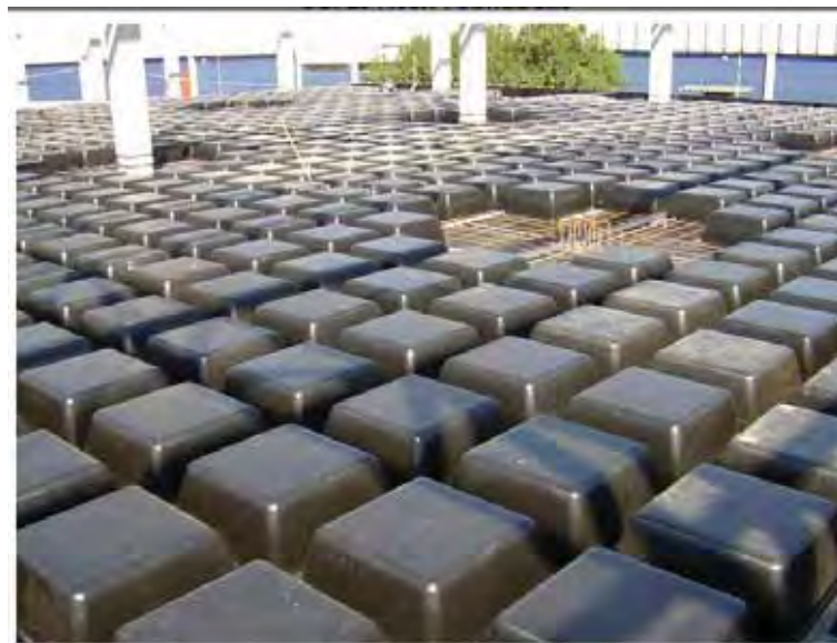
Figura 40 – Laje nervurada sendo executada ( www.atex.com.br )
