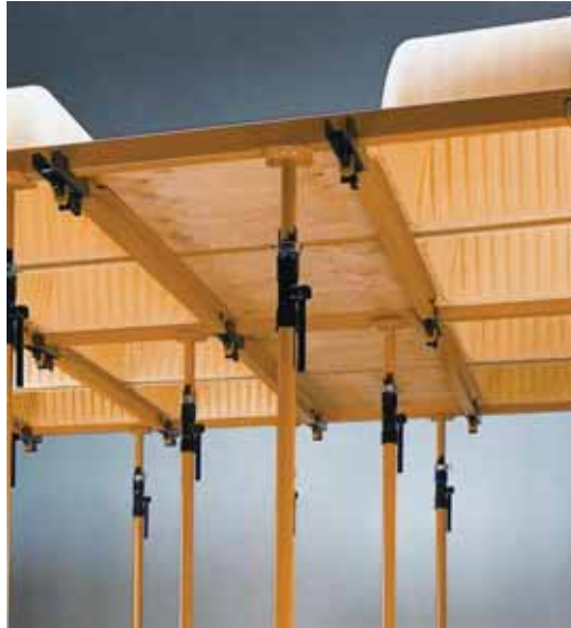
Figura 27 – Escoramento posicionado ( www.ulma-c.fr )
