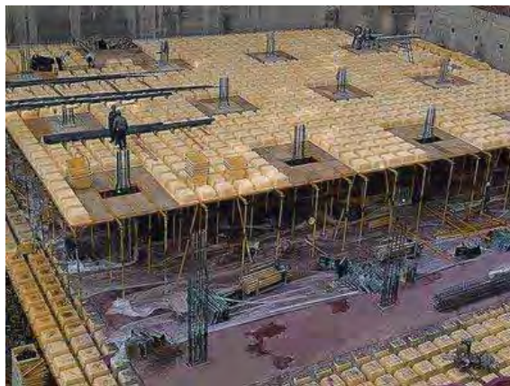
Figura 28 - Execução de laje nervurada com fôrmas de polipropileno ( www.ulma-c.fr )
