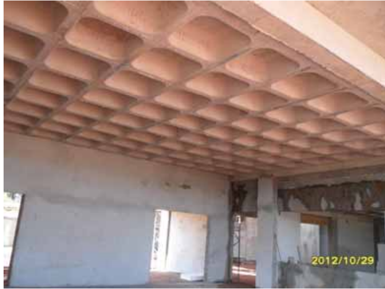
Figura 21 - Laje nervurada em execução na UNESP – Guaratinguetá (FONTE: Autor)
