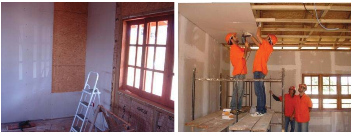
Figura 11: Aplicação do gesso e do rejunte nas paredes e forros internos.
