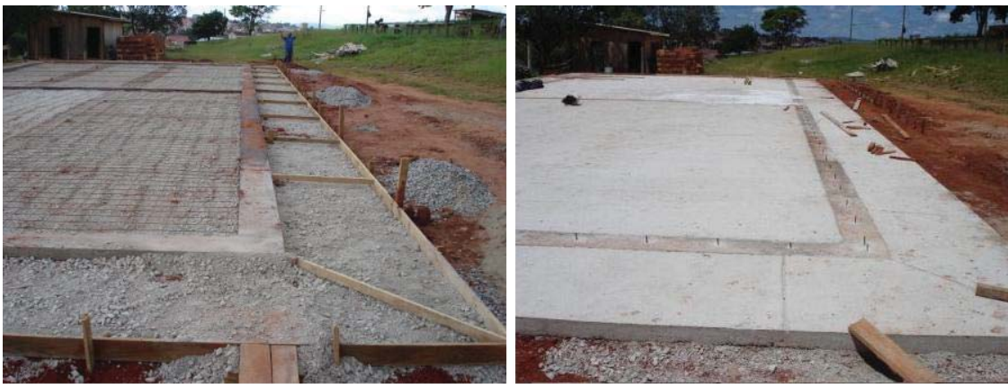
Figura 2: Preparação das bases e do contra-piso.
