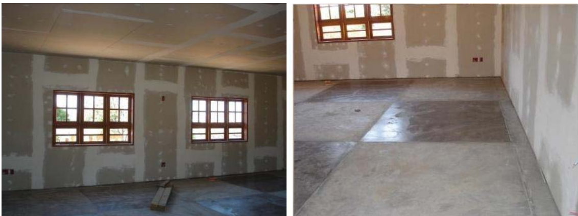
Figura 12: Pintura das paredes internas.
