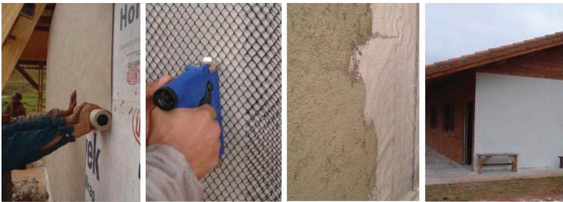
Figura 8: Revestimento externo tipo stucco.
