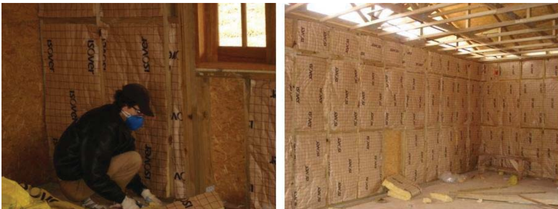
Figura 9: Aplicação das mantas de isolamento térmico.
