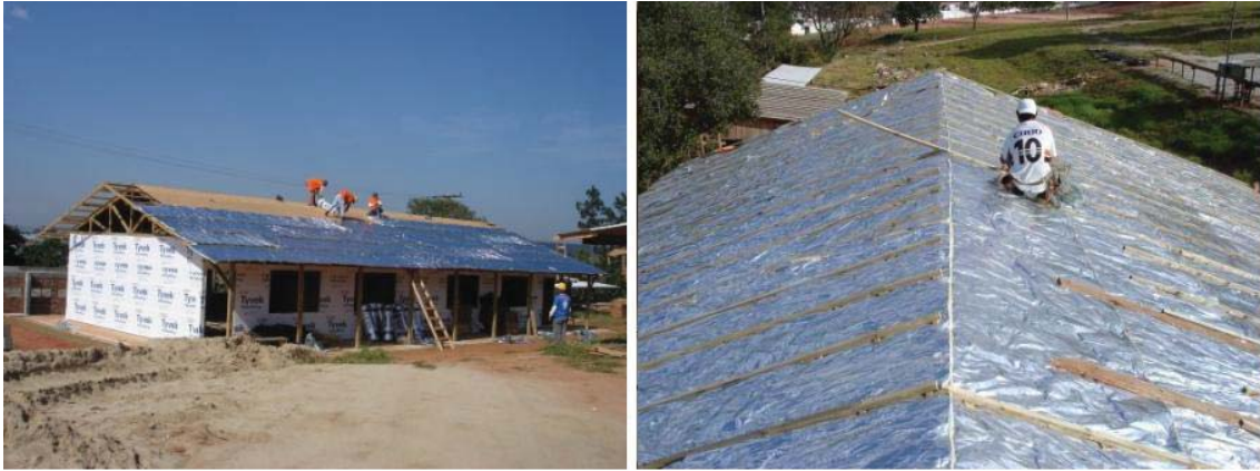
Figura 7: Aplicação das mantas de isolamento térmico.
