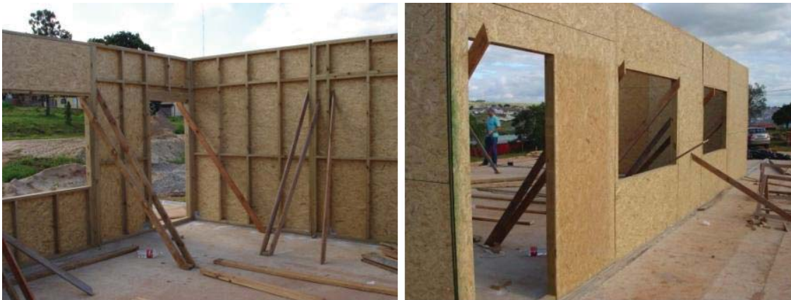
Figura 3: Paredes com OSB.
