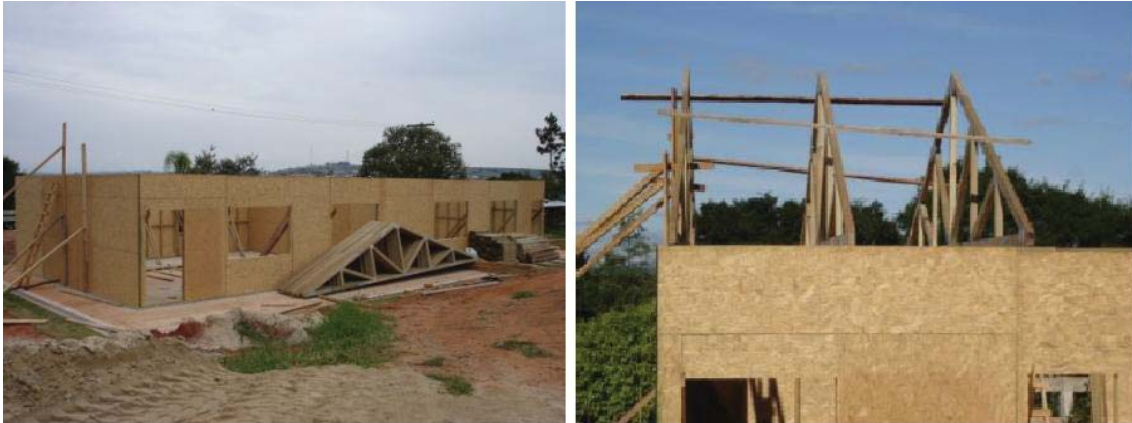
Figura 4: Montagem das paredes das salas e fixação das tesouras.
