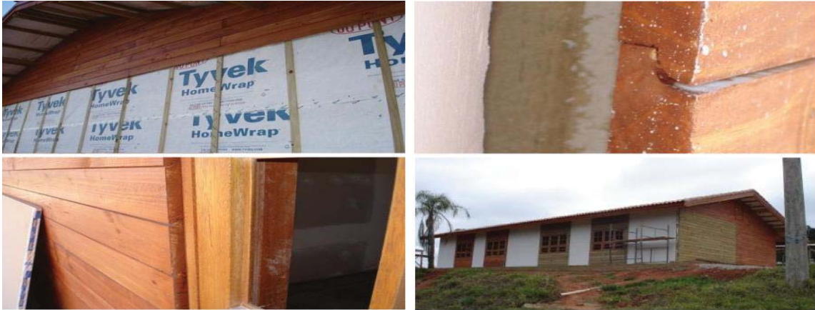
Figura 10: Fixação dos siddings .
