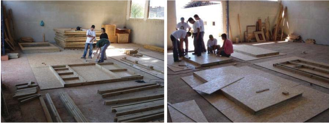
Figura 1: Pré-fabricação dos painéis.
