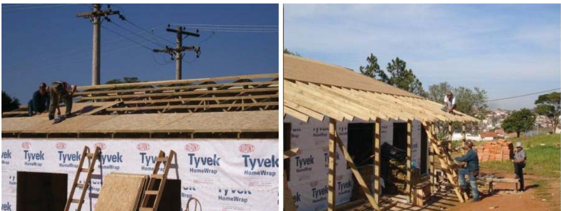
Figura 6: Colocação do forro de OSB.
