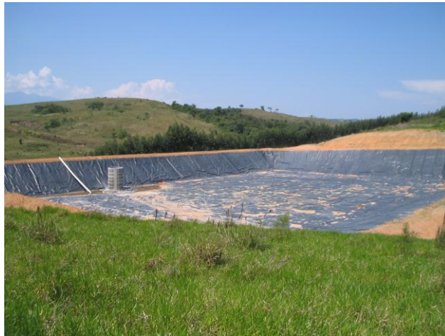
Figura 9 - Tubulação para recepção de efluentes provenientes do lixo. (fonte: arquivo do aterro sanitário de Cachoeira Paulista – SP).
