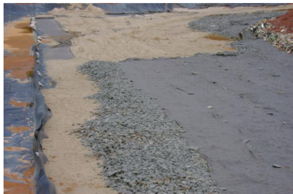
Figura 7 - Colocação de brita e geotêxtil para proteção da geomembrana e facilidade de escoamento dos fluidos. (fonte: arquivo do aterro sanitário de Cachoeira Paulista – SP).
