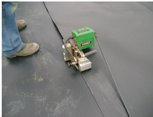
Figura 5 - Soldagem das geomembranas sintéticas de impermeabilização. (fonte: arquivo do aterro sanitário de Cachoeira Paulista – SP).
