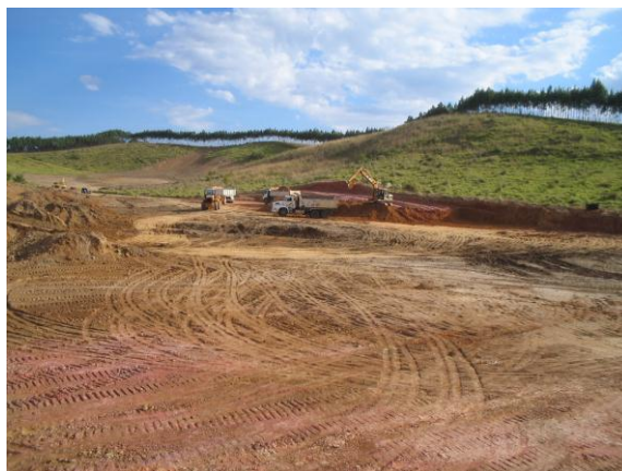
Figura 3 - Compactação do solo na instalação do Aterro de Cachoeira Paulista. (fonte: arquivo do Aterro Sanitário de Cachoeira Paulista - SP)
