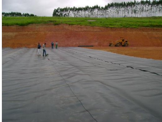
Figura 4 - Preparação para soldagem das mantas impermeáveis. (fonte: arquivo do aterro sanitário de Cachoeira Paulista - SP).
