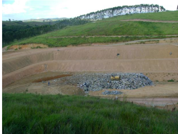
Figura 11 - Cobertura diária do lixo no aterro sanitário. (fonte: arquivo do aterro sanitário de Cachoeira Paulista – SP).
