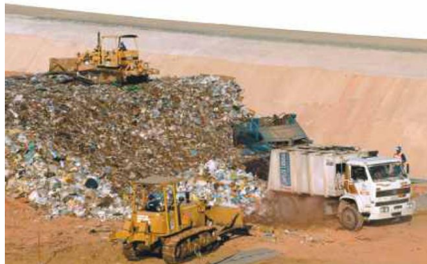
Figura 10 - Deposição e compactação do lixo. (fonte: Manual de Operações de Aterro Sanitário - BA < http://www.conder.ba.gov.br/manual_aterro.pdf >)
