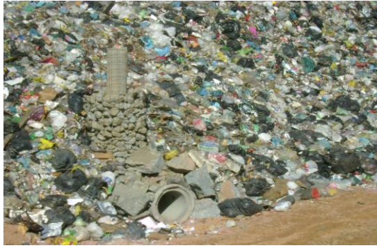
Figura 6 - Existência de brita para facilitar o escoamento de fluidos e não obstruir a passagem dos gases. (fonte: arquivo do aterro sanitário de Cachoeira Paulista – SP).
