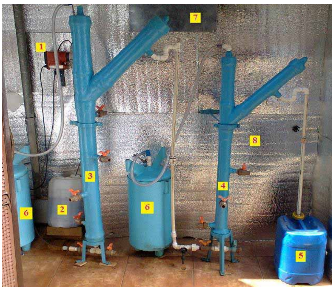
FIGURA 5. Foto dos reatores anaeróbios (sistema R1+ R2) de fluxo ascendente com manta de lodo (UASB). (1) – Bomba diafragma; (2) - Tanque de armazenamento do afluente; (3) – Reator UASB (R1); (4) - Reator UASB (R2); (5) – Tanque de armazenamento do efluente; (6) Gasômetros; (7) – Sistema de aquecimento; (8) – Isolamento térmico.
