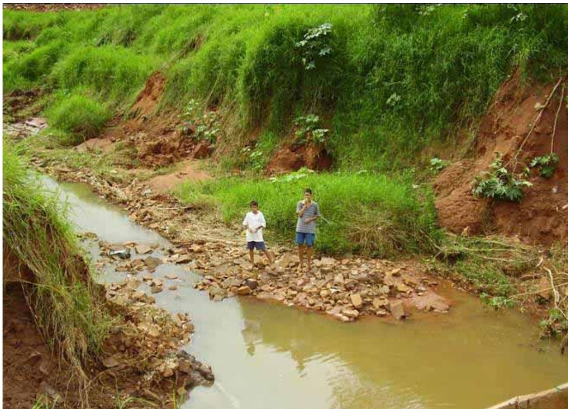
Figura 7 - Trecho do Córrego Bela Vista com forte erosão.
