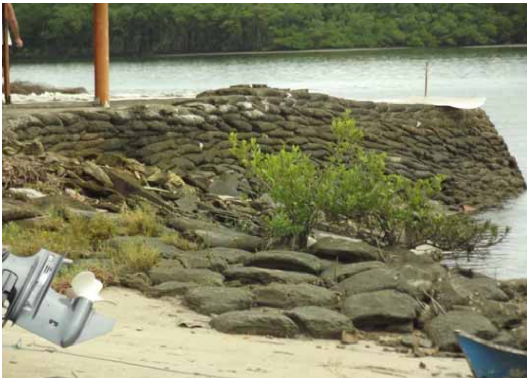
Fotografia 6: Sacos de contenção colocados sobre a frente da casa de Dona Maria, na Enseada da Baleia para mitigar o impacto dos processos erosivos sobre sua casa.
