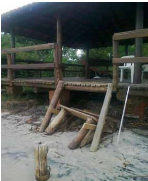
Fotografias 2 e 3: “Estrutura de apoio à visitação danificada por erosão costeira prosseguia sem reparos durante visita de reportagem da equipe de Reportagem da Carta Capital e fragilidades de estruturas de apoio à pesquisa do Parque, vê-se detalhe das paredes do alojamento mostrando fiação elétrica exposta.” (Nogueira, 2004) Fonte: Mirian Nogueira, 2014.
