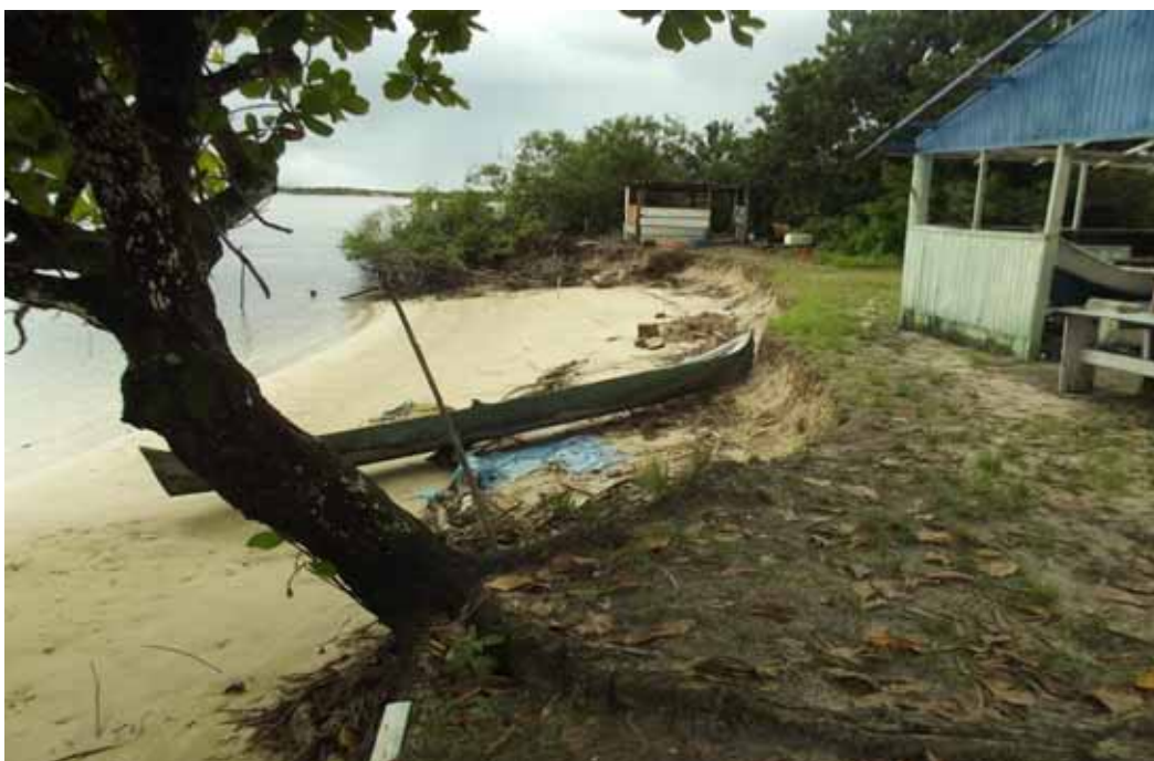
Fotografia 5 : Ocorrência dos Processos erosivos no Núcleo Enseada da Baleia. Fonte: Jéssica de Lima Silva, 2013.
