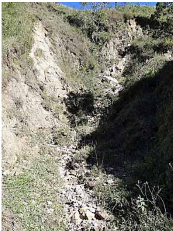
Figura 22 – Área afetada pela erosão
