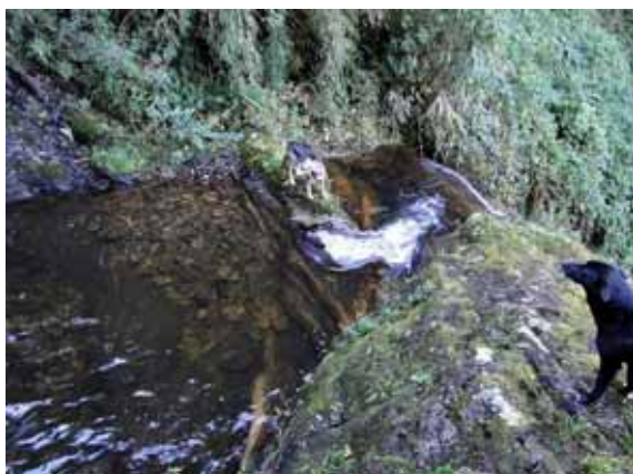
Figura 21 – Erosão encontrada a beira da estrada que leva a propriedade.
