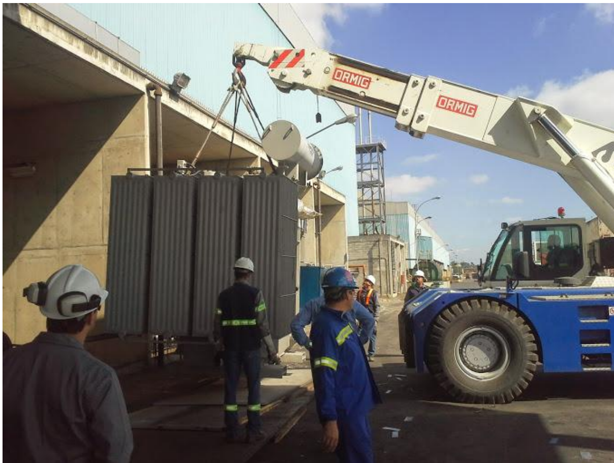
Figura 4.9 – Substituição dos transformadores.
