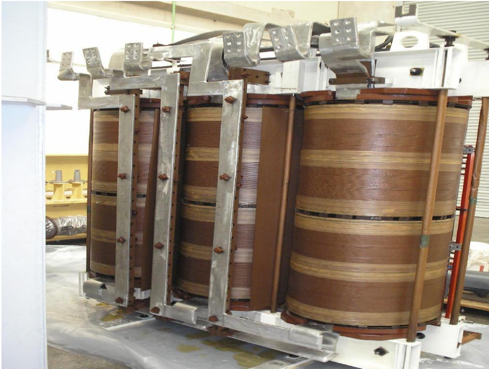
Figura 4.7 – Barramento distorcido após o arco elétrico.
