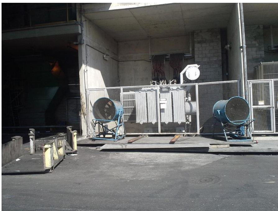
Figura 4.8 – Ventilação forçada sobre o transformador reserva.
