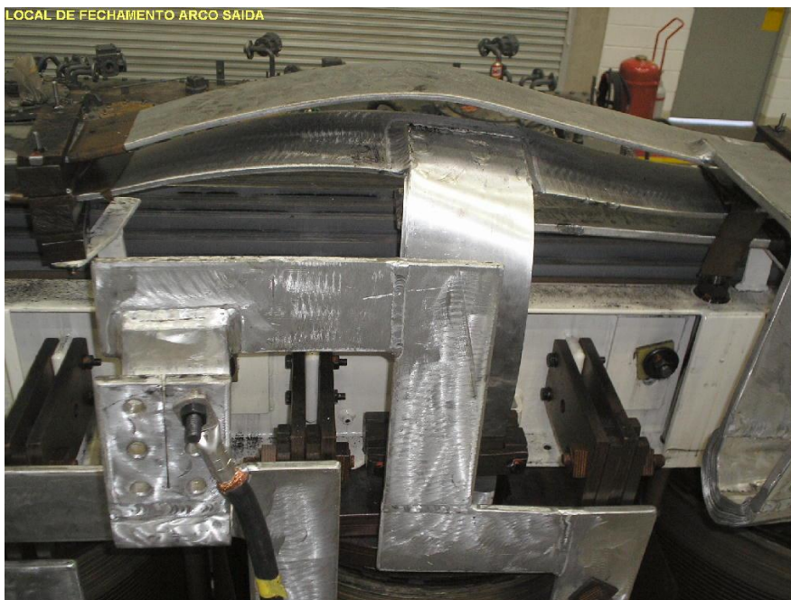
Figura 4.6 – Ação do arco elétrico sobre a estrutura do transformador.
