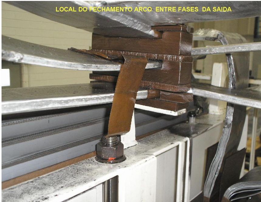
Figura 4.5 – Estrutura distorcida após o arco elétrico.
