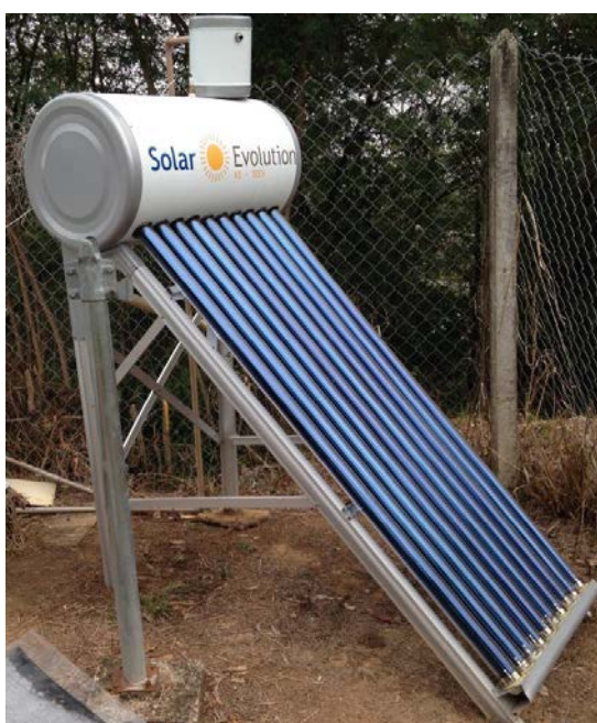
Figura 7: Sistema de aquecimento solar de água com tubos a vácuo
