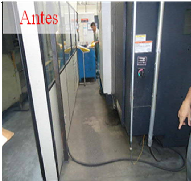
Figura 13 - Fotografia da fiação da máquina no meio da passagem
