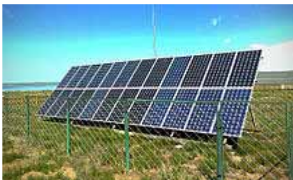
Figura 2.1- Painel fotovoltaico com 24 módulos.
