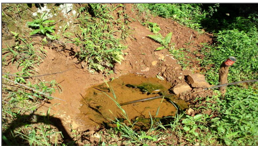
Figura 30. Nascente do Ribeirão do Jacú antropizada sem a devida proteção.
