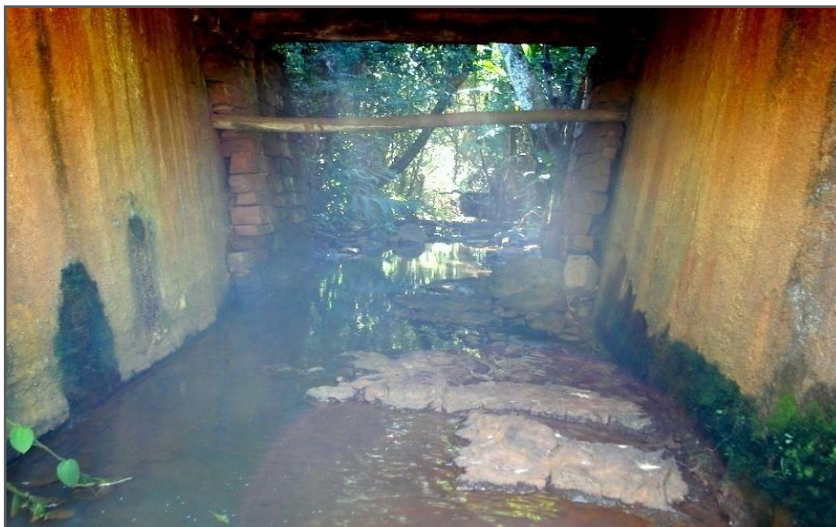
Figura 31. Galeria por onde se escoa a água da nascente do Ribeirão do Jacú.
