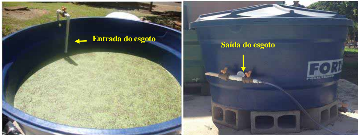
Figura 7- Entrada do esgoto e local de coleta (esquerda) e Saída do esgoto e local de coleta (direita)
