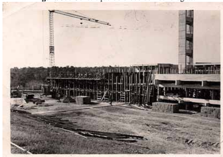
Figura 35: Construção do bloco de Tecnologias.
