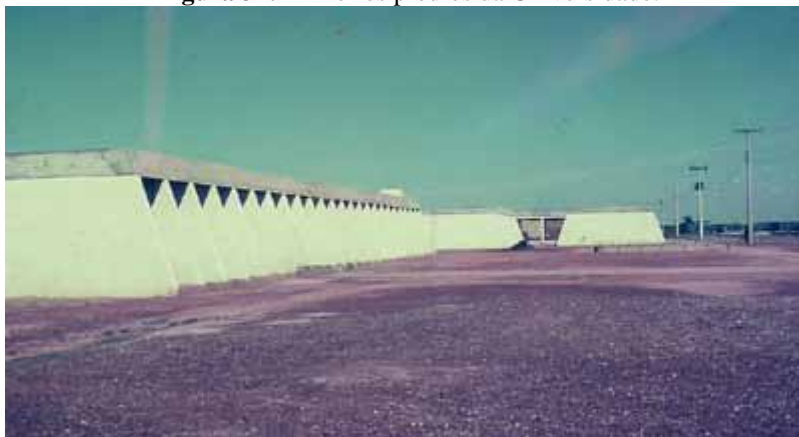
Figura 31: Primeiros prédios da Universidade.
