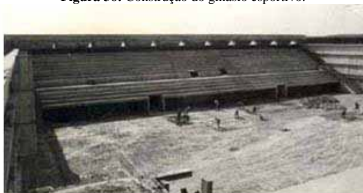
Figura 36: Construção do ginásio esportivo.
