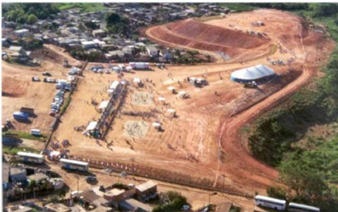
Foto 1 – Obras de recuperação do maciço realizadas no ano de 2002. Destaca-se a diferença no tratamento dado a porção oeste do aterro (esquerda da foto), onde se verificam taludes bem definidos, e a porção leste do aterro (direita da foto), onde se verifica o domínio da vegetação.
