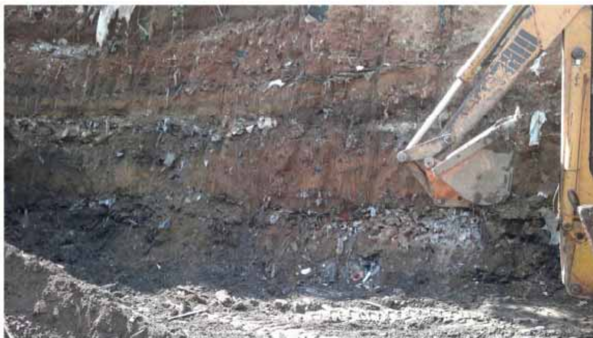
Foto 2 – Obras para triagem na porção sudoeste do aterro. Verifica-se camadas de resíduos alternadas com camadas de solo de no máximo 1m. Destaca-se que o maciço se mostra estável durante os procedimentos de escavação, mesmo sujeitado a taludes de quase 90°.
