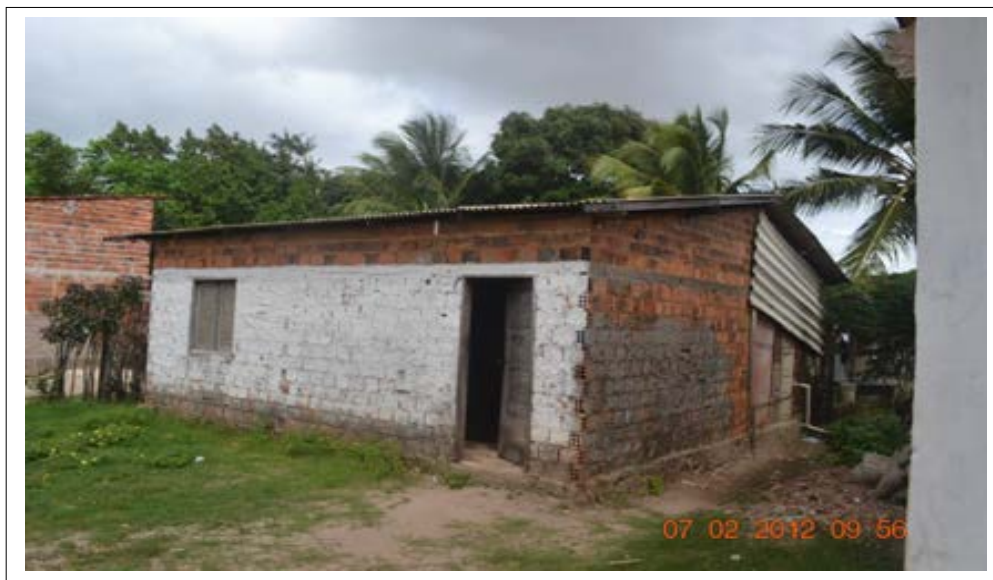
Figura 46. P2. Casa de alvenaria (sem reboco) com cobertura de telha de fibrocimento Fonte: ARAUJO, R. R. Registro fotográfico de trabalho de campo (fev./2012)
