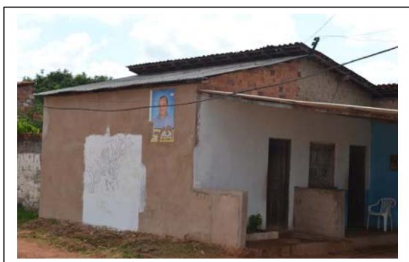
Figura 99. P5. Casa de alvenaria com cobertura de telha de fibrocimento
