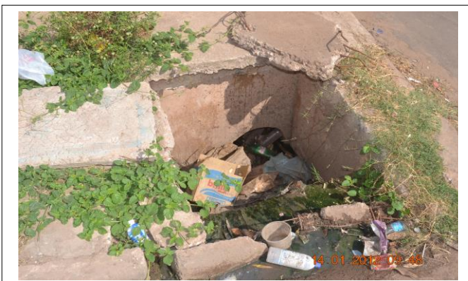
Figura 28c. Lixo depositado nas caixas de esgoto.
