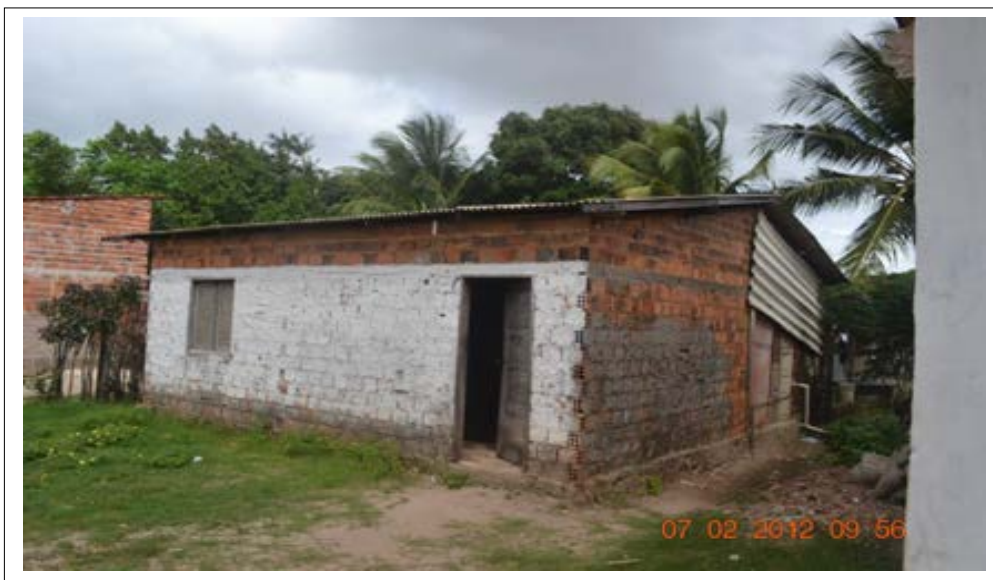
Figura 38. P2. Casa de alvenaria (sem reboco) com cobertura de telha de fibrocimento Fonte: ARAUJO, R. R. Registro fotográfico de trabalho de campo (fev./2012)
