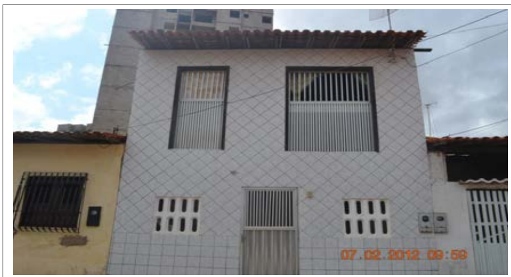
Figura 47. P3. Casa de alvenaria de 2 pavimentos (com revestimento de azulejos) com cobertura de telha de cerâmica e laje Fonte: ARAUJO, R. R. Registro fotográfico de trabalho de campo (fev./2012)
