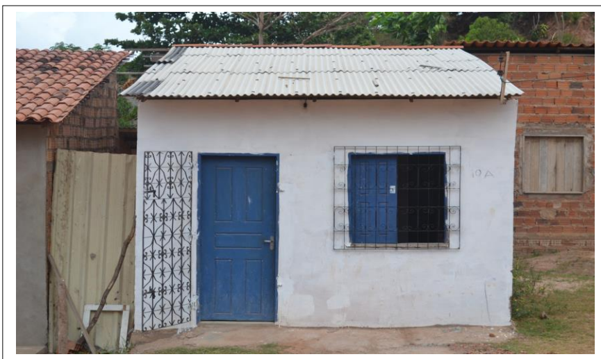
Figura 64. P6. Casa de alvenaria (com reboco) com cobertura de telha de fibrocimento Fonte: ARAUJO, R. R. Registro fotográfico de trabalho de campo (nov./2012)
