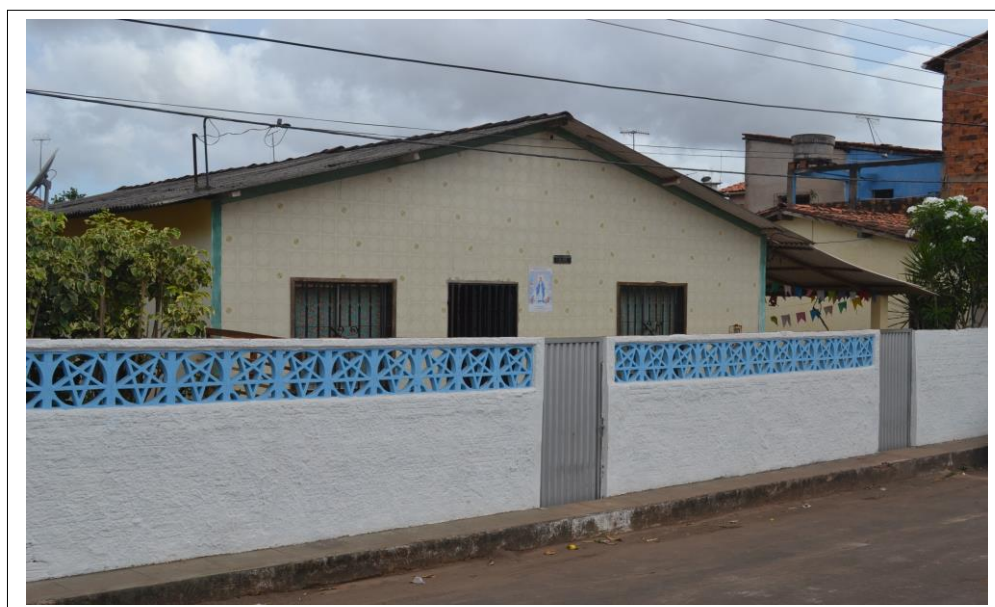
Figura 76. P9. Casa de alvenaria (com revestimento de azulejos) com cobertura de telha de fibrocimento. Fonte: ARAUJO, R. R. Registro fotográfico de trabalho de campo (nov./2012)
