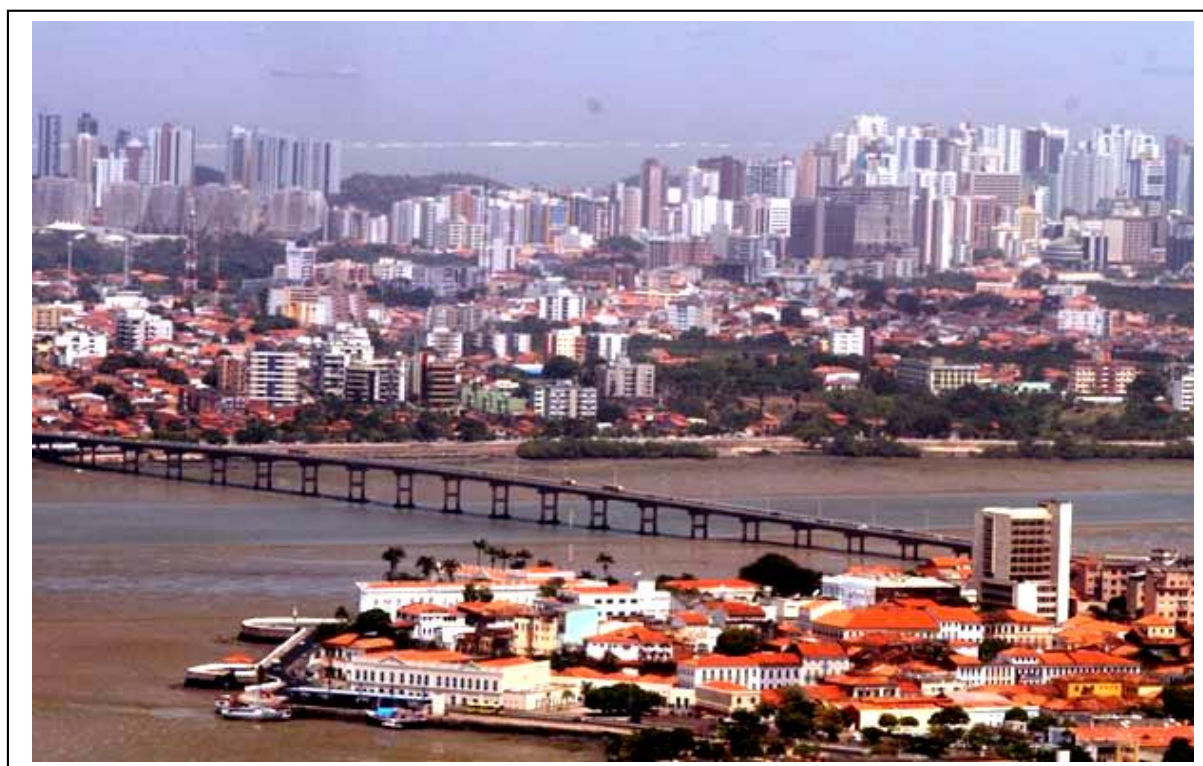
Figura 22. Ponte Gov. José Sarney sobre o rio Anil, ligando a São Luís antiga com a moderna.
