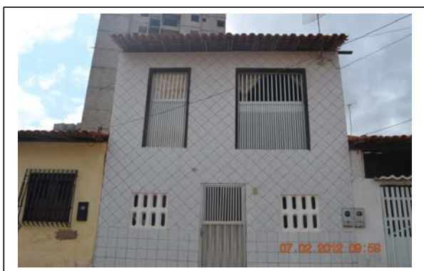
Figura 95. P3. Casa de alvenaria de 2 pavimentos com cobertura de telha de cerâmica e laje Fonte: ARAUJO, R. R. (fev./2012)
