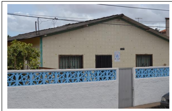
Figura 108. P9. Casa de alvenaria com cobertura de telha de fibrocimento
