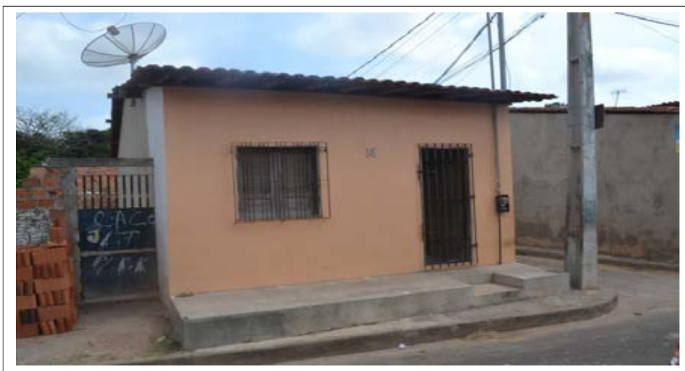
Figura 37. P1. Casa de alvenaria rebocada com cobertura de telha de cerâmica Fonte: ARAUJO, R. R. Registro fotográfico de trabalho de campo (out./2012)
