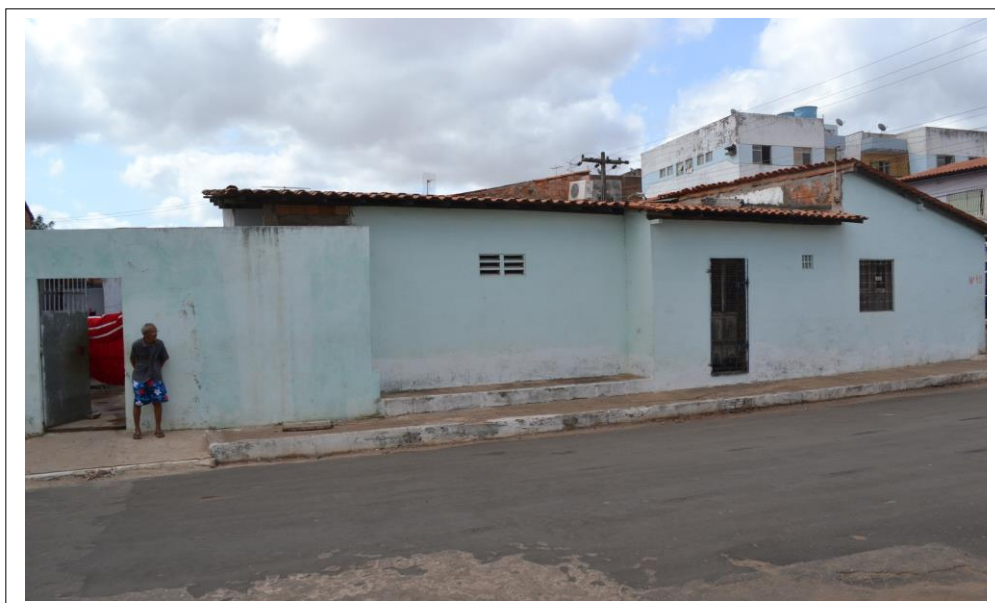
Figura 75. P8. Casa de alvenaria (com reboco) com cobertura de telha de cerâmica. Fonte: ARAUJO, R. R. Registro fotográfico de trabalho de campo (dez./2012)
