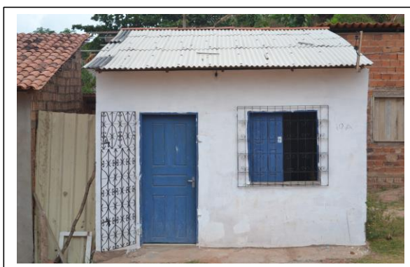
Figura 100. P6. Casa de alvenaria com cobertura de telha de fibrocimento
