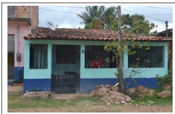
Figura 102. P7. Casa de alvenaria com cobertura de telha de cerâmica
