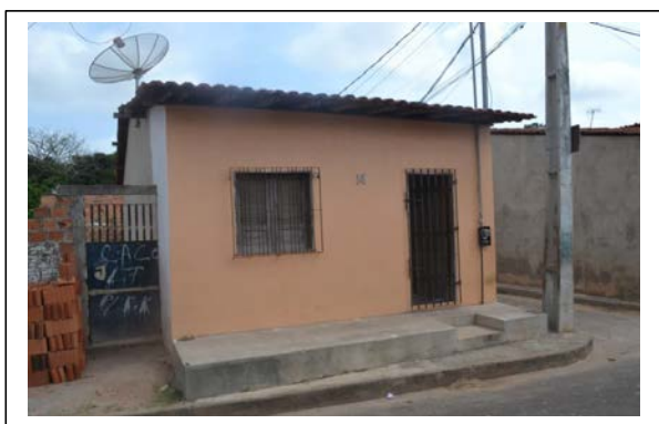
Figura 93. P1. Casa de alvenaria com cobertura de telha de cerâmica Fonte: ARAUJO, R. R. (out./2012)
