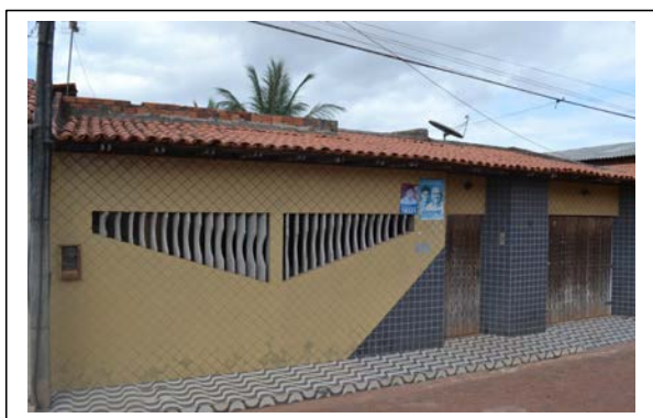
Figura 101. P4. Casa de alvenaria com cobertura de telha de cerâmica
