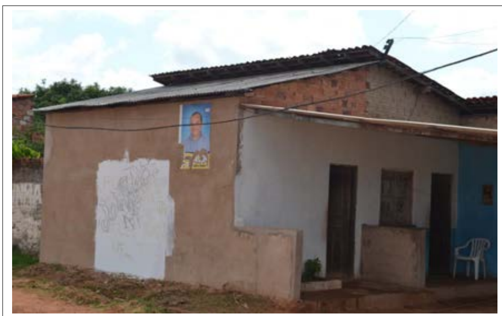
Figura 56. P5. Casa de alvenaria (com reboco) com cobertura de telha de fibrocimento. Fonte: ARAUJO, R. R. Registro fotográfico de trabalho de campo (nov./2012)
