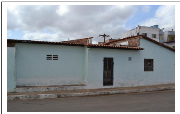
Figura 107. P8. Casa de alvenaria com cobertura de telha de cerâmica
