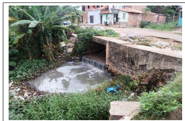
Figura 35b. Despejo de esgoto a céu aberto na Forquilha Fonte: http://gilbertolimajornalista.blogspot.com.br (acesso em mai./2012)
