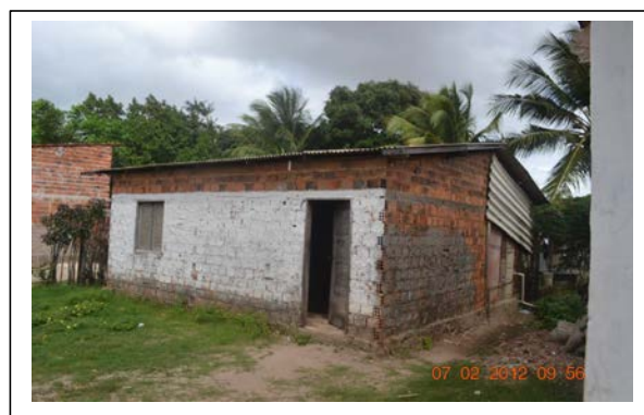
Figura 94. P2. Casa de alvenaria com cobertura de telha de fibrocimento Fonte: ARAUJO, R. R. (fev./2012)
