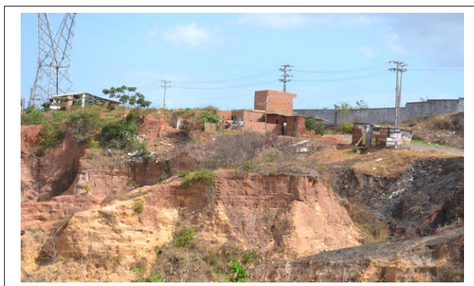
Figura 32e. Casas em área de risco na Salinas do Sacavém.
