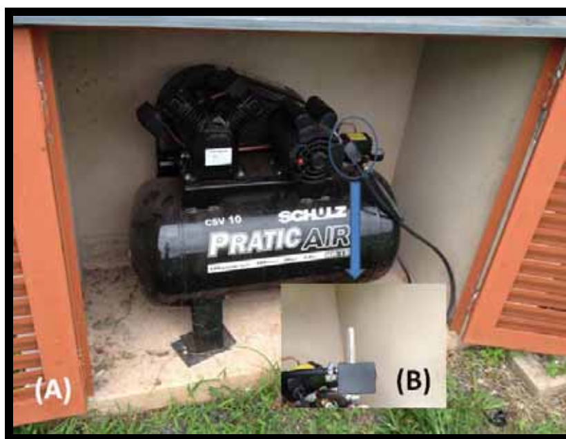
Figura 4.9 (A) Vista frontal do compressor de ar. (B) Rotâmetro utilizado para controle de vazão de ar.
