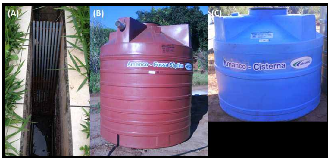
Figura 4.3 (A): Gradeamento; (B): Decantador primário; (C) Tanque de equalização.
