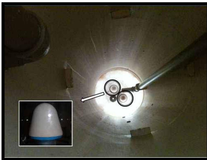
Figura 4.8 Local de instalação dos difusores de ar, com detalhe do difusor utilizado.
