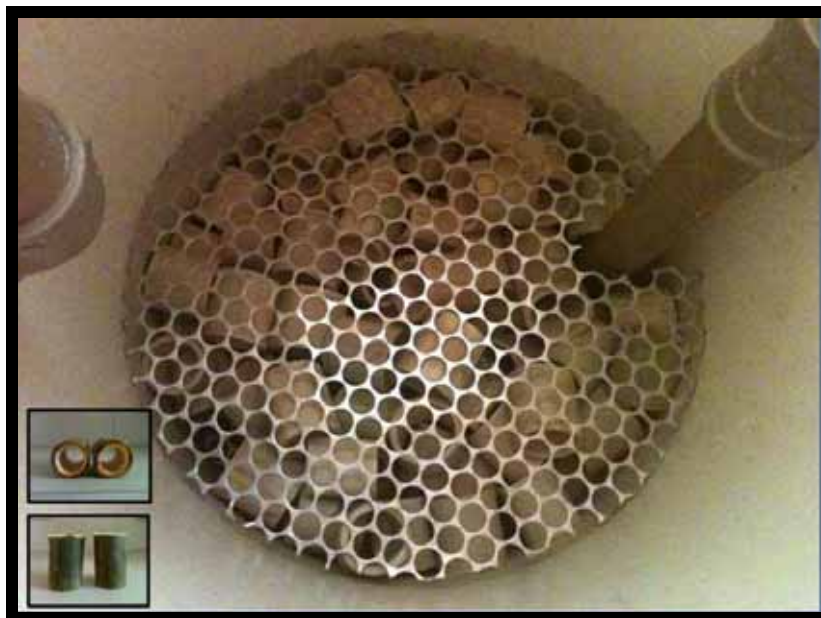
Figura 4.10 Anéis de bambu e suporte de metal, instalados dentro da câmara aeróbia do RCAA.
