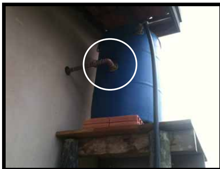
Figura 4.4 Tanque de controle de vazão
