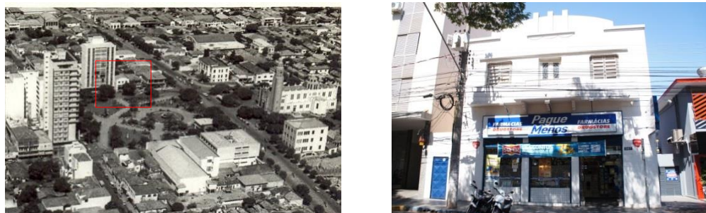
Figura 39 - (a) vista superior do centro histórico de Presidente Prudente em 1960, (b) estado atual da edificação em estudo.
