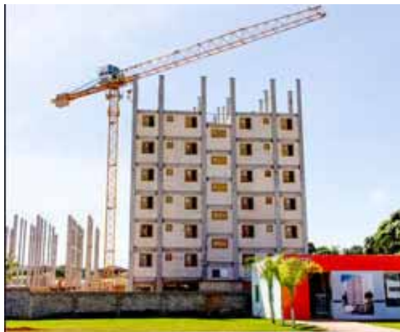
Figura 4 - Guindaste de torre Liebherr, utilizado para a construção de um prédio.
