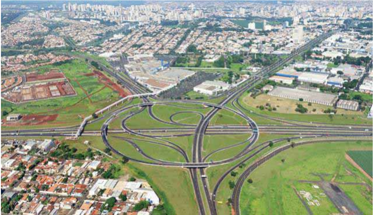
Foto 1 - Ribeirão Preto. Foto aérea do "Trevão", 2014.
