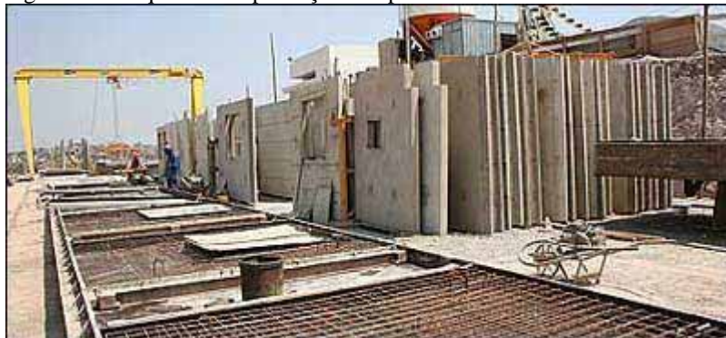
Figura 04 - Sequência de produção dos painéis de concreto
