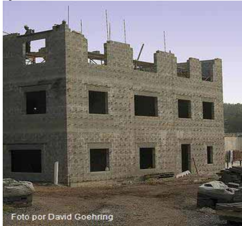
Figura 03 - Sistema convencional de alvenaria estrutural
