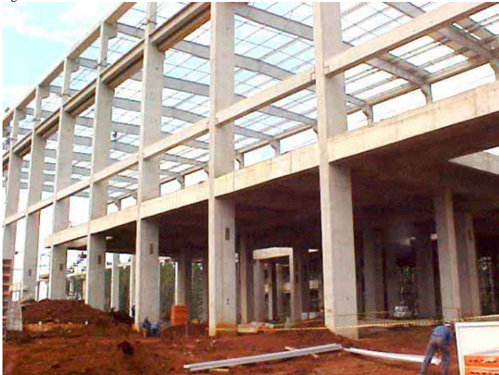
Figura 02 - Estrutura em concreto armado convencional
