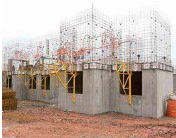
Figura 32 - Parede de concreto com armação de espera em tela soldada
