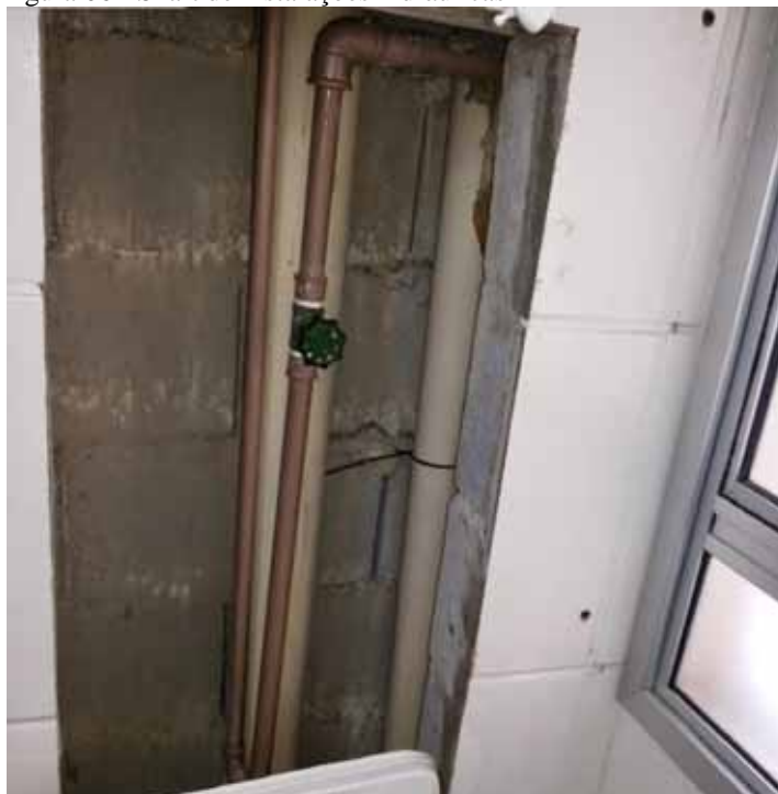
Figura 06 - Shaft de instalações hidráulicas
