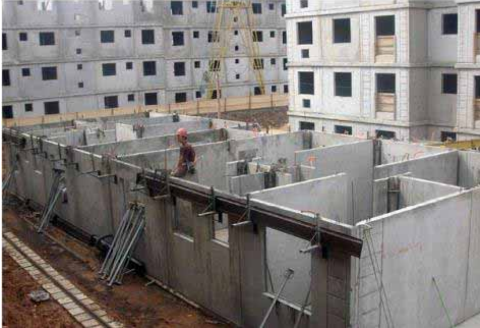
Figura 08- Painéis pré-moldados em suas disposições finais
