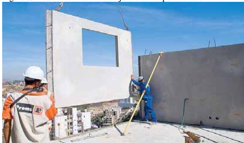
Figura 09 - Painel com abertura de janela sendo posicionado
