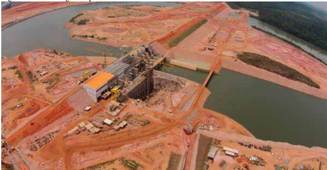
Figura 02 - Obra de grande porte no setor de infraestrutura
