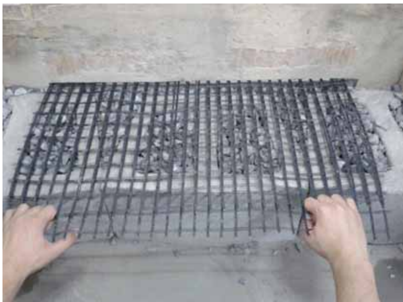
Figura 21 - Extremidade da geogrelha sendo tracionada manualmente
