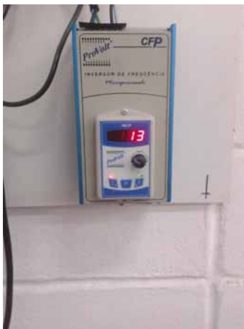
Figura 14- Inversor de Frequência ProVolt
