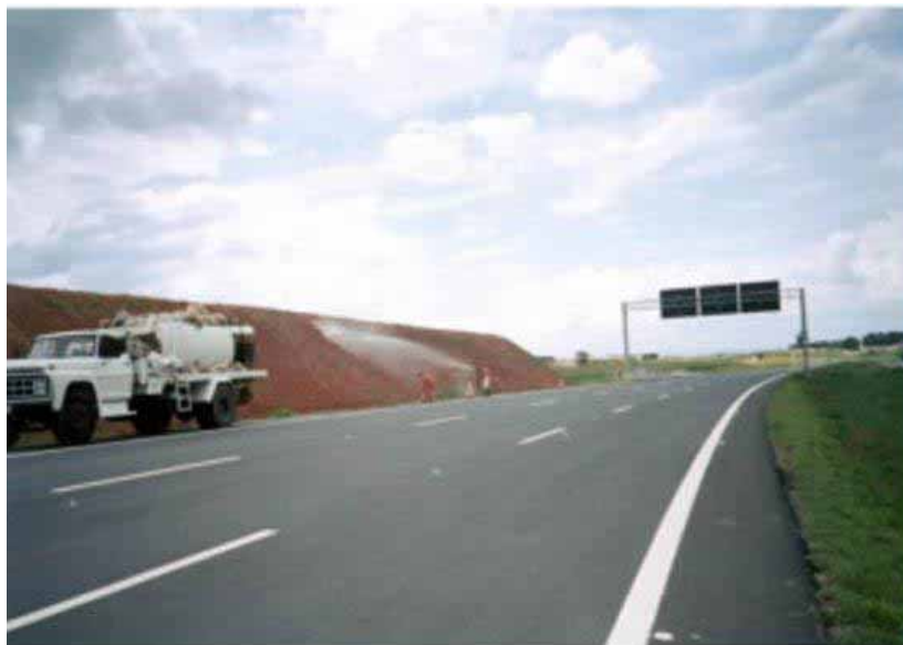
Figura 17: Execução da hidrossemeadura: lançamento por hidrojetamento à altas pressões.
