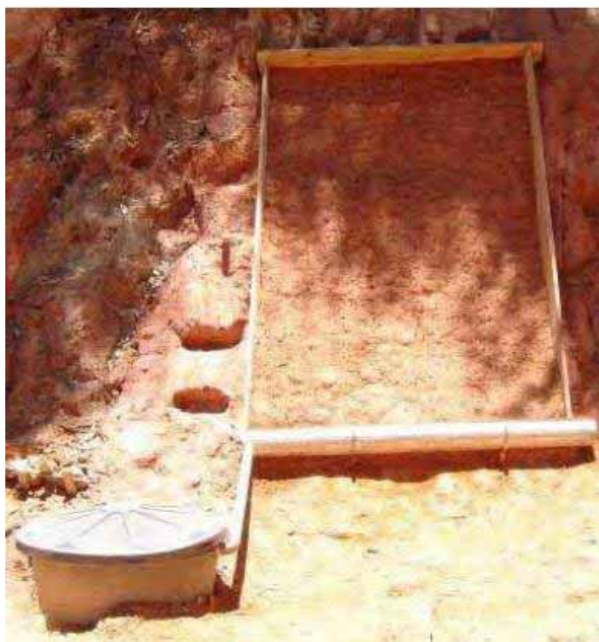
Figura 22: Solo compactado diretamente sobre o talude, de forma manual.
