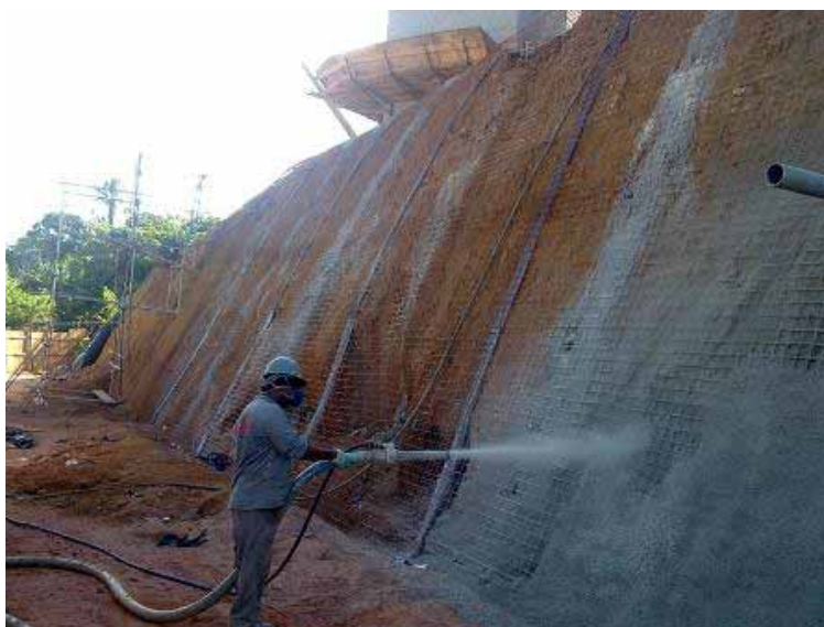
Figura 7: Execução de concreto projetado sobre a superfície de um talude.
