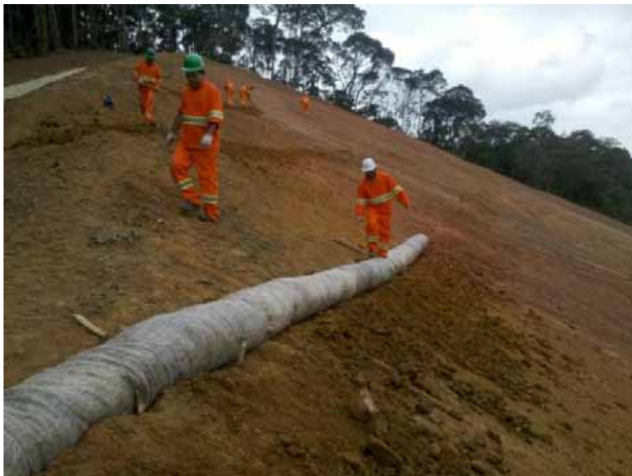
Figura 20: Abertura de nichos e fixação com piquetes de madeira.
