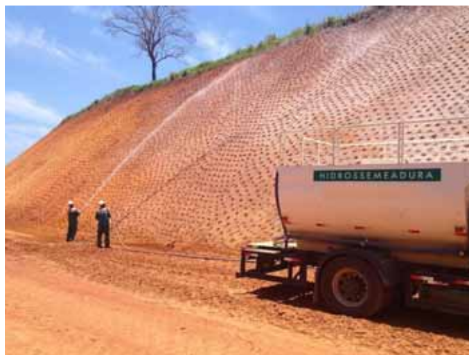
Figura 18: Hidrossemeadura em taludes de corte.
