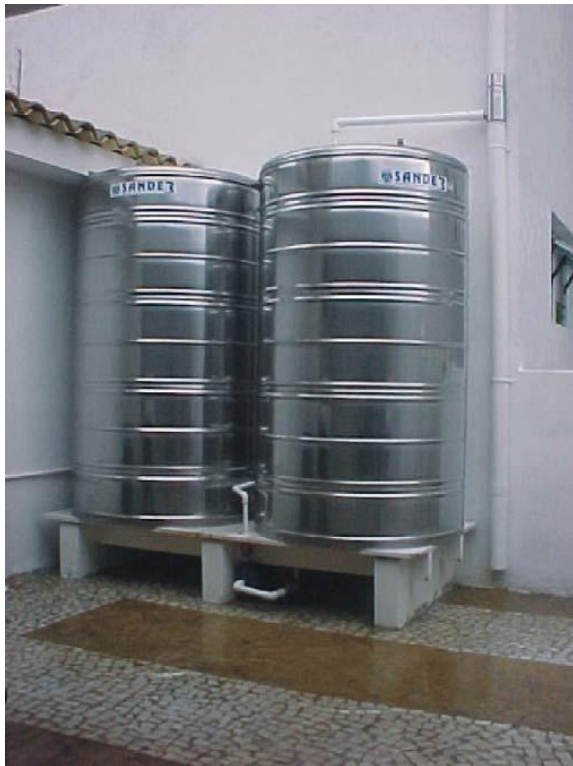
Figura 16: Dois reservatórios de aço inox com 2.000 litros cada.
