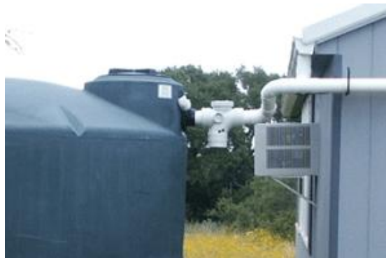
Figura 26: Detalhe da válvula para descarte inicial de água pluvial.
