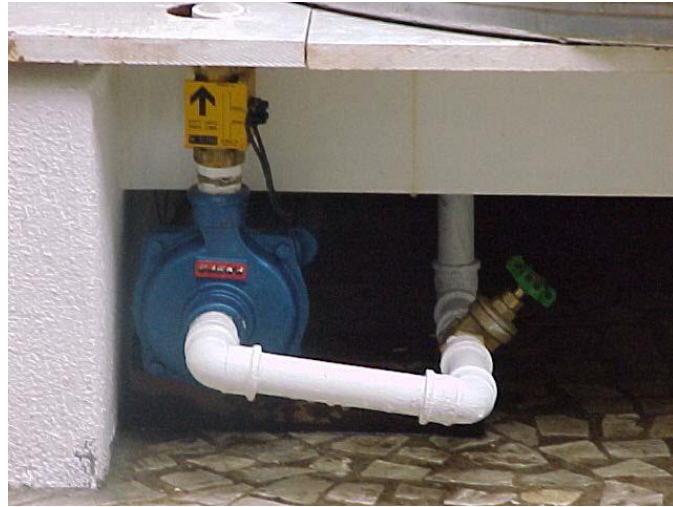
Figura 22: Motor usado para bombeamento da água de chuva.
