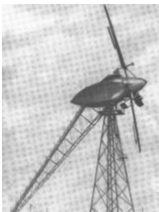
Figura 3 – Turbina Eólica Balaclava
