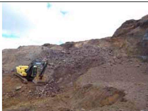
Figura 6.13: Magnetitito friável na frente de lavra (Mineração Mtransminas Minerações Ltda).
