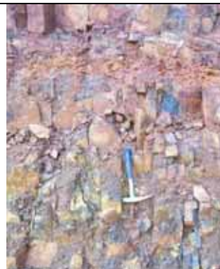
Figura 7.14: Detalhe do magnetitito, muito fraturado e com vestígios de bandas carbonáticas de coloração amarela.
