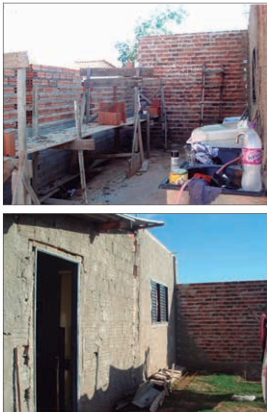
Figura 8 – Projeto Casa de Viviane Carricho dos Santos Silva. Fotos da obra, 2013
