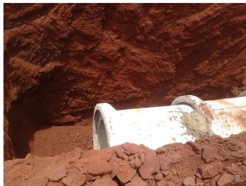
Figura 2.4 – Tubulação de água pluvial após ser instalada
