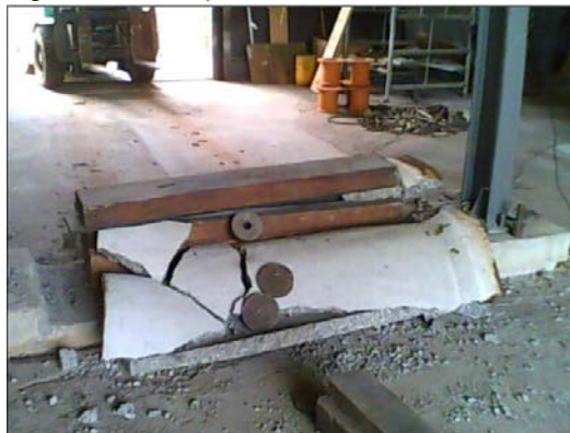
Figura 2.7 – Ruptura do Tubo
