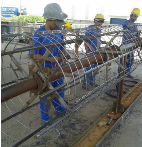
Figura 3.17 – Fixação das espiras
