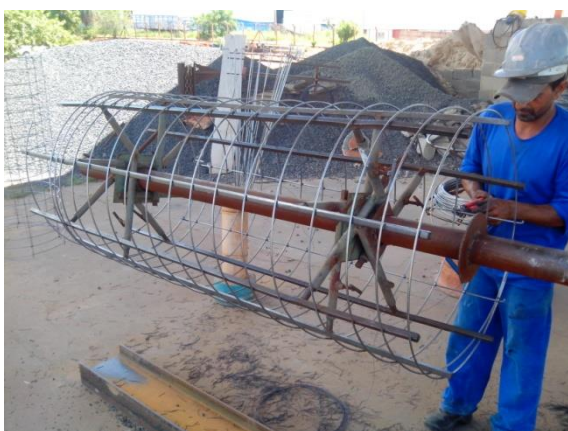
Figura 3.8 – Detalhe da montagem das armaduras transversais e longitudinais
