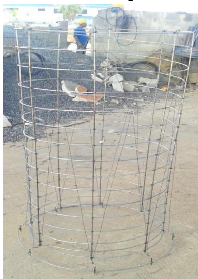
Figura 3.19 – Armação Finalizada
