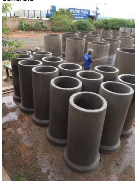
Figura 3.25 – Cura dos tubos de concreto
