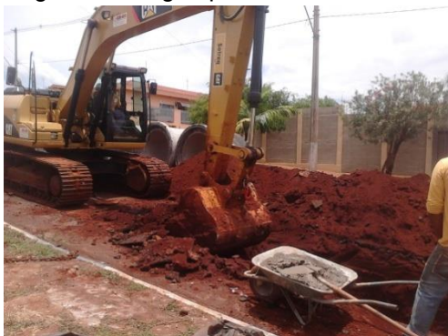
Figura 2.3 – Corte do Terreno para confecção de galeria de água pluvial
