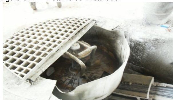
Figura 3.21 – Detalhe do misturador
