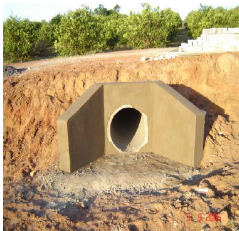
Figura 2.2 – Travessia em Rodovia Rural
