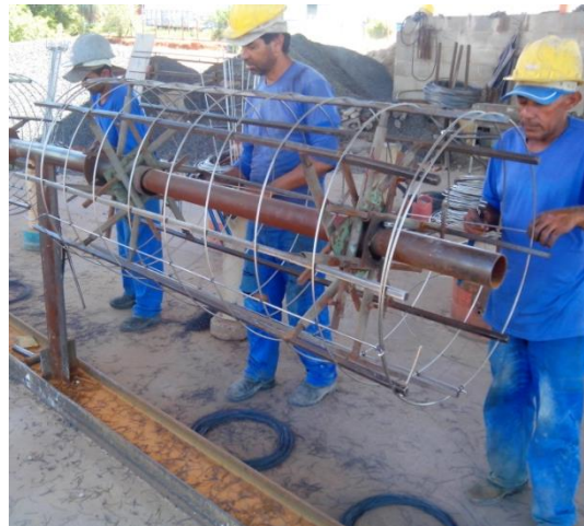
Figura 3.18 – Fixação das armaduras longitudinais
