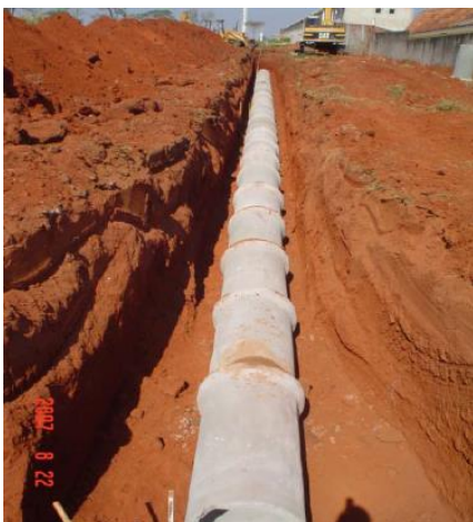
Figura 2.1 – Tubulação de Esgoto Sanitário
