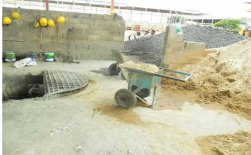
Figura 3.20 – Colocação dos agregados
