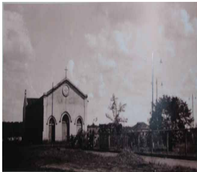
Imagem 35: Nova edificação da Igreja de Santo Antônio, construída em 1922, na Rua XV de Novembro Fonte: Arquivo Imagético do ARCA
