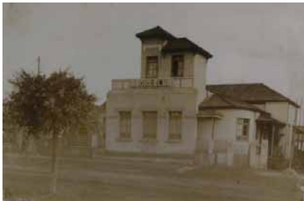
Imagem 40: Sede do Rádio Club em construção. Década de 1920. Fonte: ARCA
