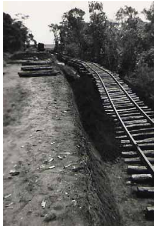
Imagem 13: Dormentes de madeira assentados diretamente na superfície, diminuindo a vida útil da linha e do material rodantes. Adoção da bitola métrica.
