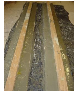
(c) Concretagem das vigas mistas
