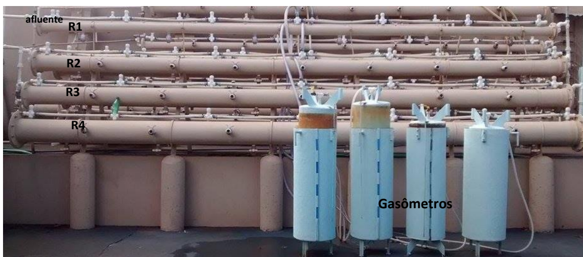
Figura 2. Foto do sistema de tratamento com os reatores anaeróbios horizontais de leito fixo e alta taxa (R1, R2, R3 e R4) e seus respectivos gasômetros.
