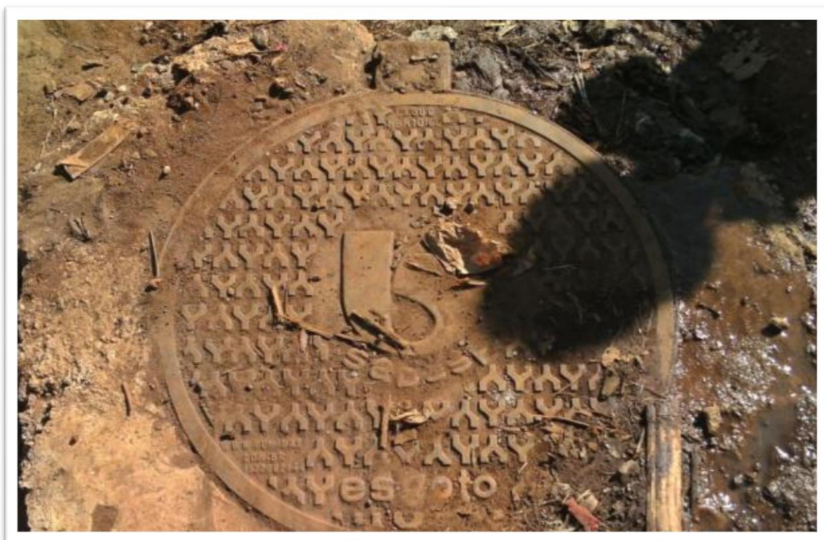
Foto 21: Rede de esgoto da TI Pyau
