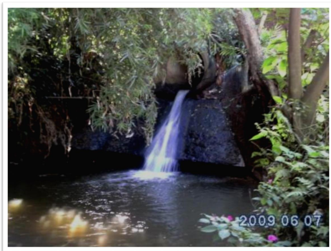
Foto 12: Tubulação de concreto que canaliza a água da lagoa ao Riacho das Lavras.
