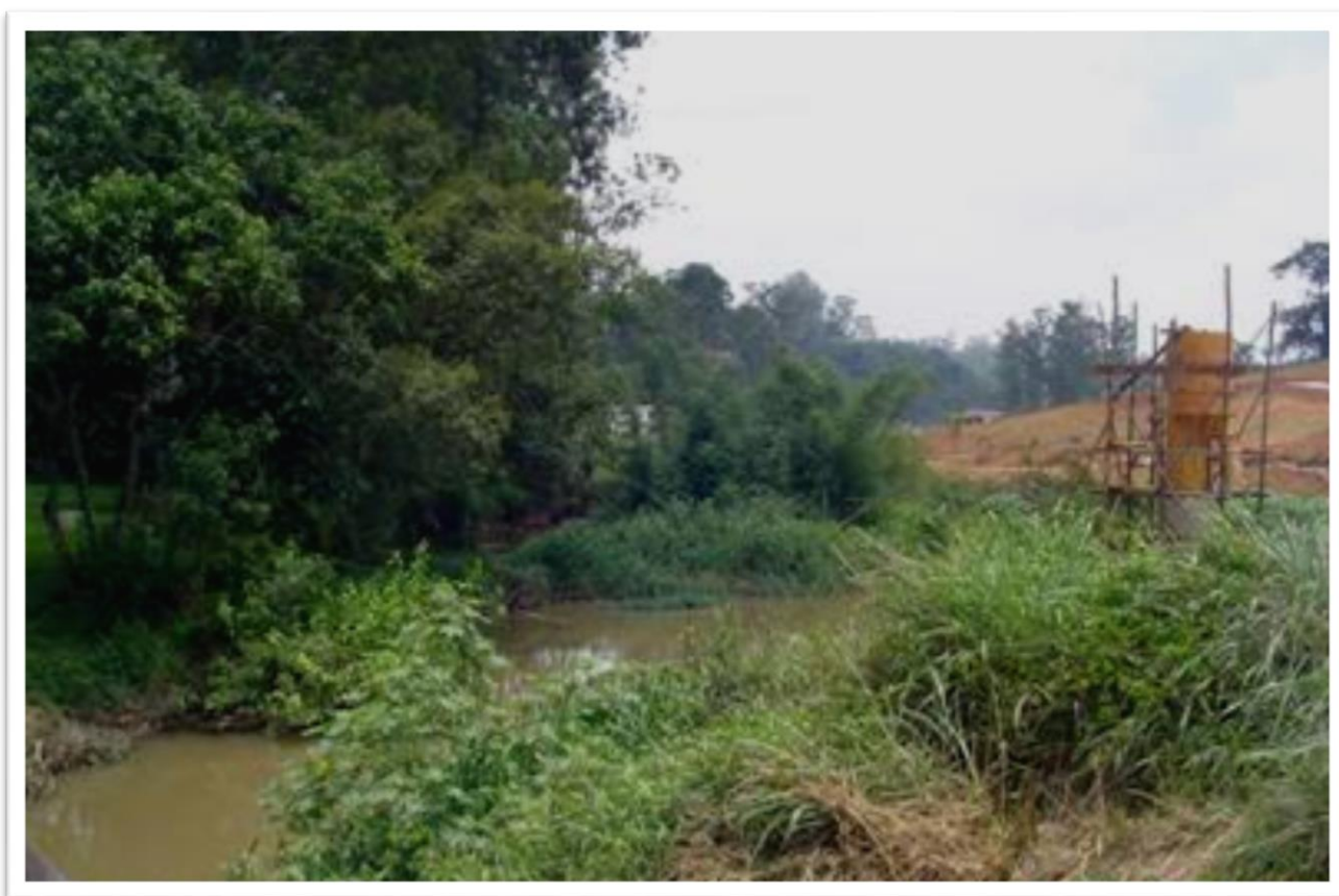
Foto 3: Poluição do riacho M'Boi Mirim com obras do Rodoanel Mário Covas (SP-021 – Trecho Sul) 28
