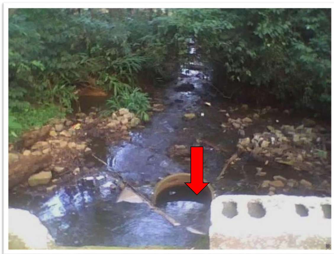
Foto 13: Decadência da obra de canalização do Riacho das Lavras no perímetro da terra indígena
