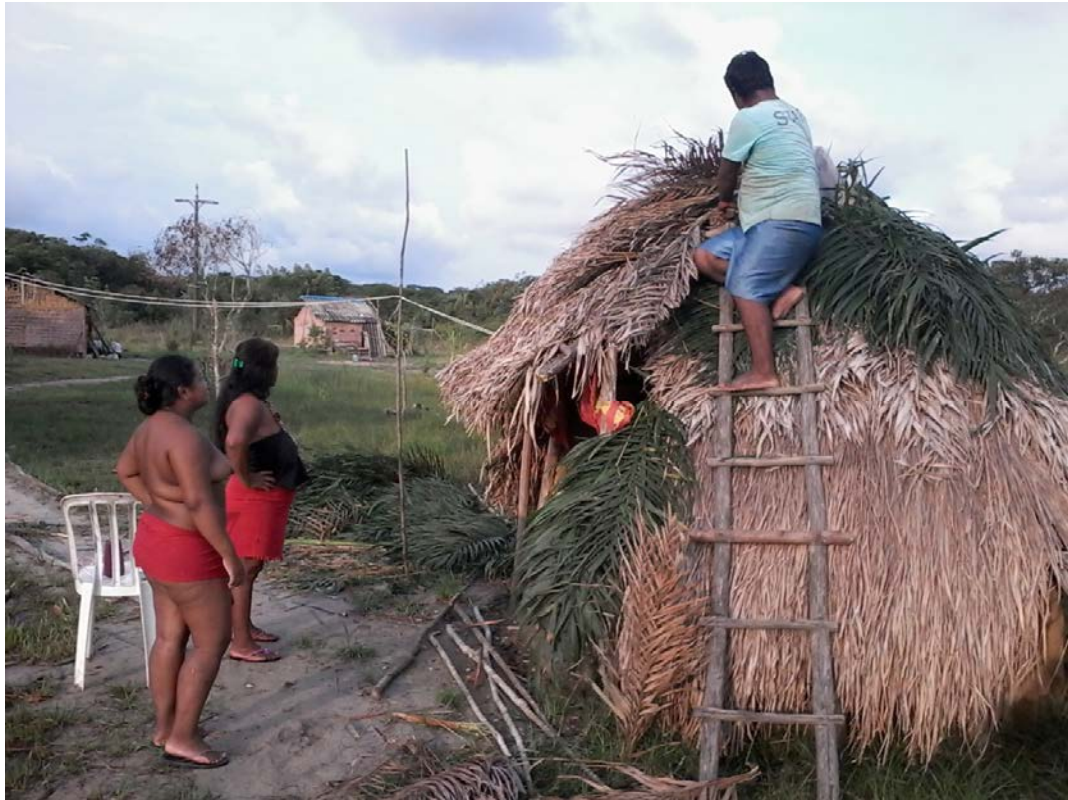
Foto 13: Arrumando o telhado. Foto: Bertapeli (2014).
