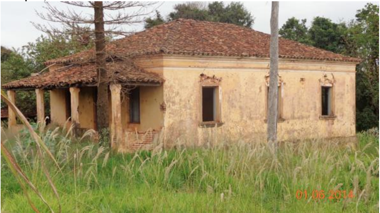
Foto 6: Sítio de pequeno produtor canavieiro onde a sede teve que ser abandonada por dificuldades financeiras. O agricultor relata que não teve coragem de demolir a casa por senti-la como parte do sítio, mas que, por dívidas, não tem condições de reformar ou manter um empregado. O agricultor mora há 30 anos na cidade de Jaboticabal. Entrevistado n°3. Tirada: 01/06/2014. Por Andréia Roviero, Jaboticabal, São Paulo.
