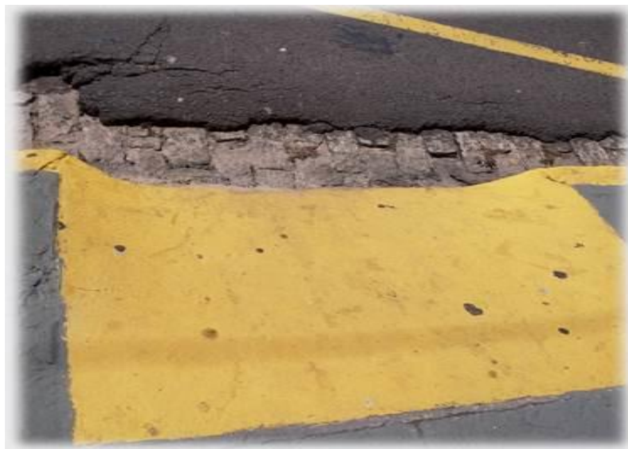
Foto 3- Rampa com elevação no centro de Presidente Prudente-SP. Fonte: ALVES, N. C. Trabalho de campo, 2014.
